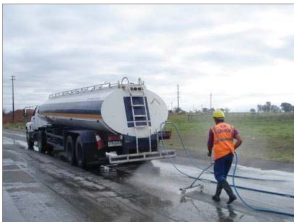
■ Figura 4. Limpieza intensiva mediante hidrolavado y posterior barrido con aire comprimido.
