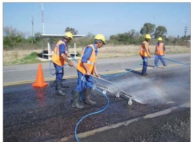
■ Figura 4. Limpieza intensiva mediante hidrolavado y posterior barrido con aire comprimido.
