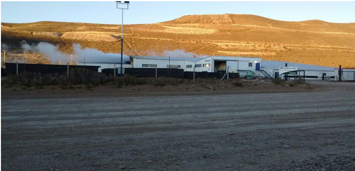
Fotografía propia del Horno Pirolítico donde se realiza el tratamiento de derrames “menores” de una operadora de la Cuenca del Golfo San Jorge.
