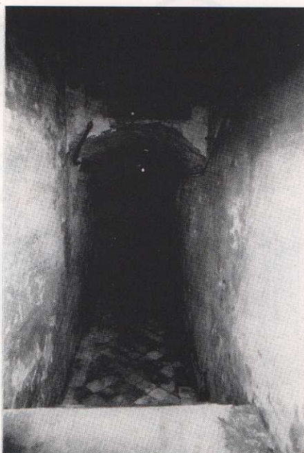
Túnel de la Rectoria. Zona intermitjana on hi ha la reixa esmentada
