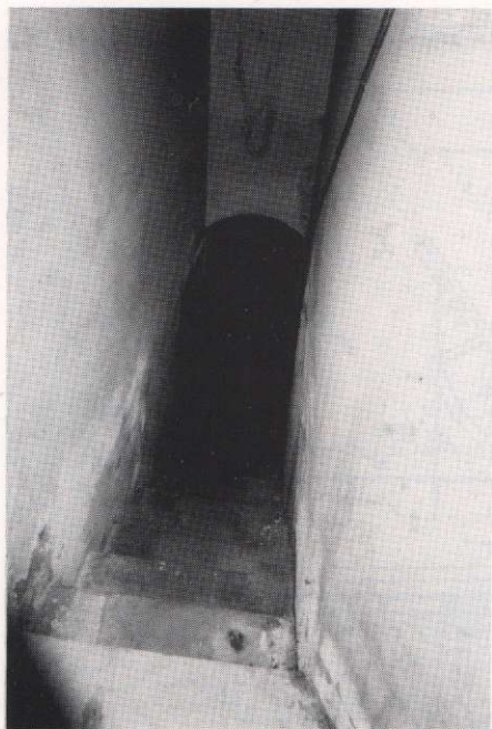
Túnel de la Rectoria. Accés des de la Rectoria
