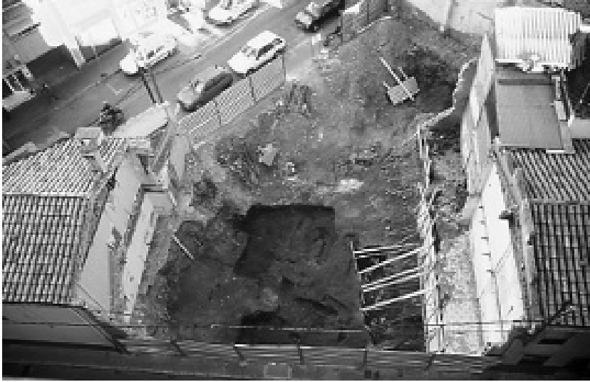
Figura 6: Vista dels solars del carrer Sevilla on es van efectuar les diferents intervencions arqueològiques, un cop finalitzats els treballs de rebaix mecànic.
