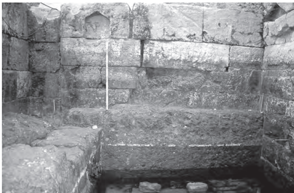
Figura 5. Detalle del muro lateral occidental desde el interior.
