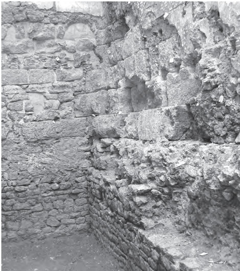
*Figura 16. Detalle de la cimentación del lateral oriental del recinto de culto mediante muro de mortero forrado de sillarejo e hileras superiores de sillares (archivo Codex).*
