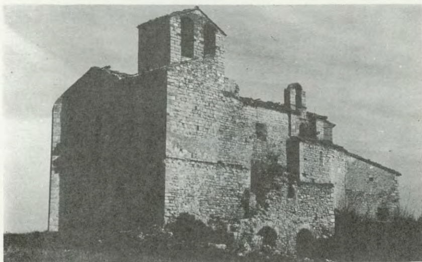
Sant Jaume de Montagut. Exterior, vista de l'església. Façanes sud i oest.
