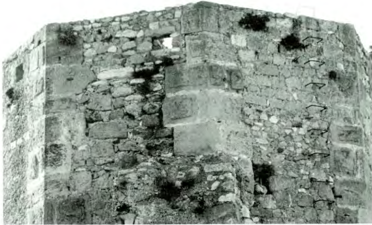
Figura 22. Angle E. S'observa el cos 4 de carreus i la diferència d'aparell del costat D-E (Compara's amb la fig. 13, que mostra aquest costat des de l'interior). Es veu també l'espitllera UE XIV des de l'interior i el remat superior del contrafort
