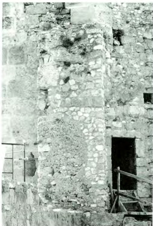
Figura 10. Contrafort al costat de l'angle E.
