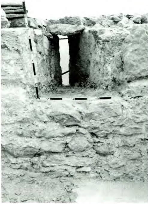
Figura 18. Vista interior de l'espitllera UE IX
