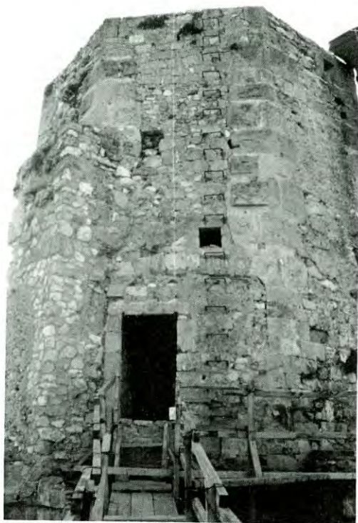
Figura 8. Vista del cos superior o sala de la torre des del costat D-E. S'observa la porta, el contrafort, la diferenciació dels carreus del cos 3 i 4 dels angles
