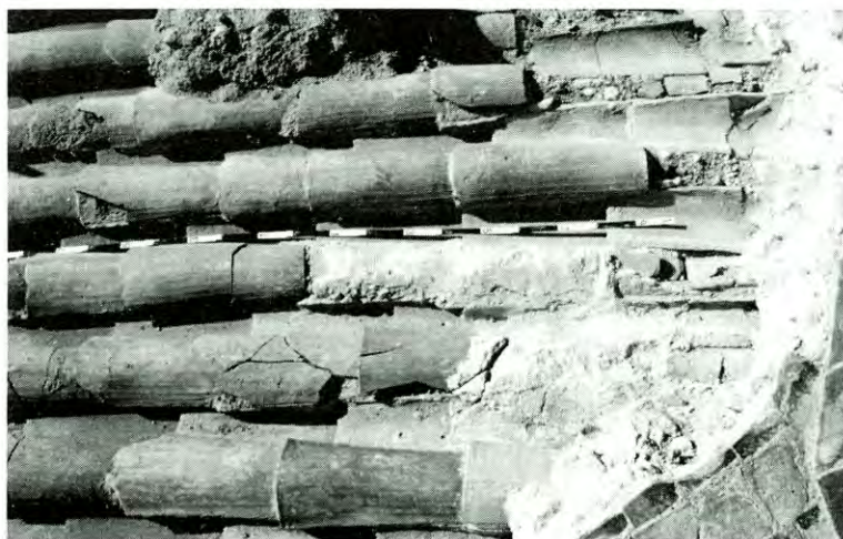
Figura 11. Aspecte de la UE 1013 al costat de l'angle E. S'observen dues teules sustiïdes per massa morter lliscat
