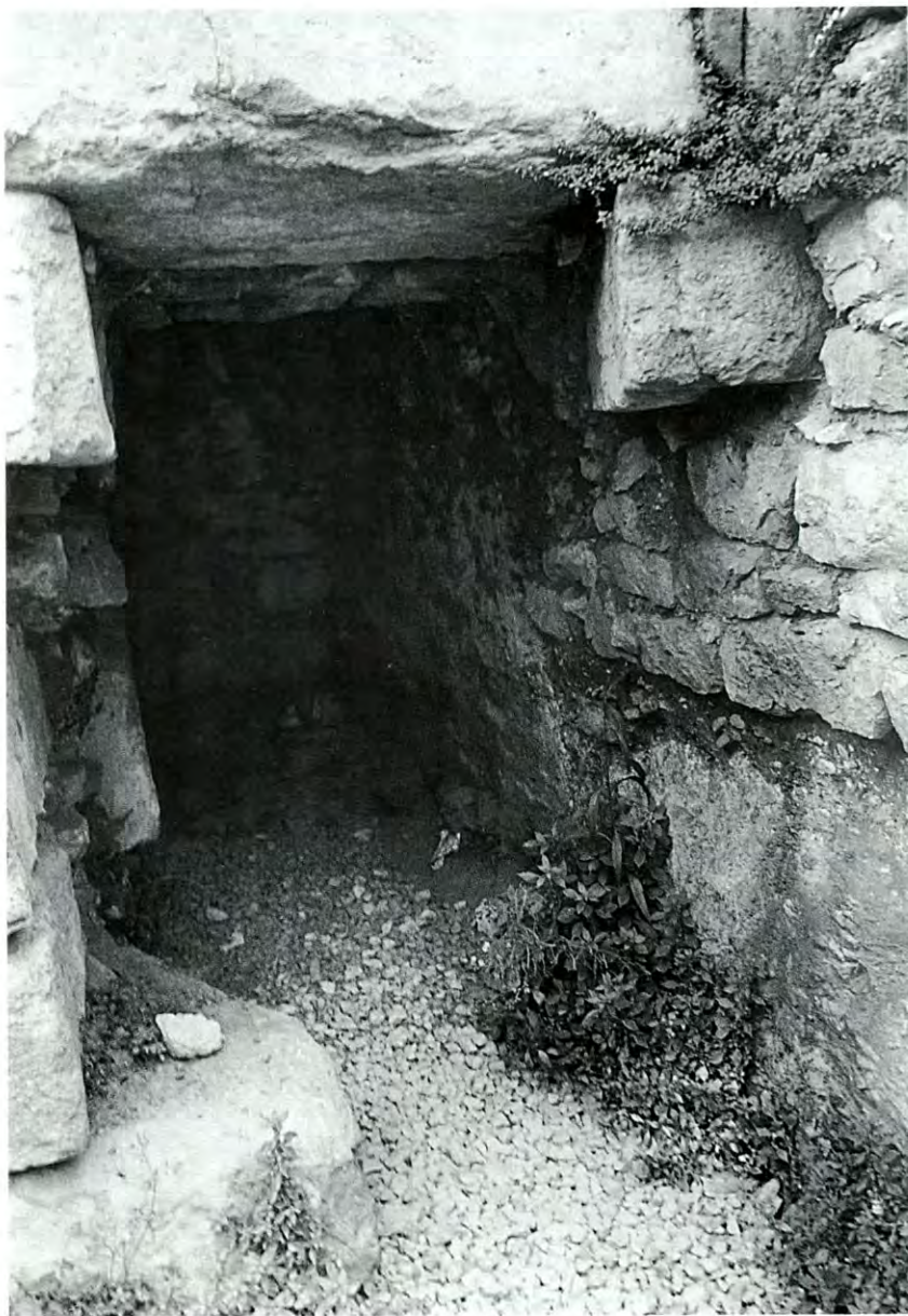
Fig. 8.—Portezuela y corredor existente entre el cimiento del muro sur de la iglesia y el cimiento de la columnata de la nave central. Obsérvese el recorte del muro este de la fosa romana. Foto: Ana Godoy.
