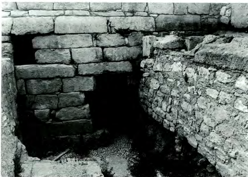
Fig. 3.—Cimentación de la fachada sur de la iglesia. Obsérvese el recorte del muro de la fosa. Foto: Ana Godoy.
