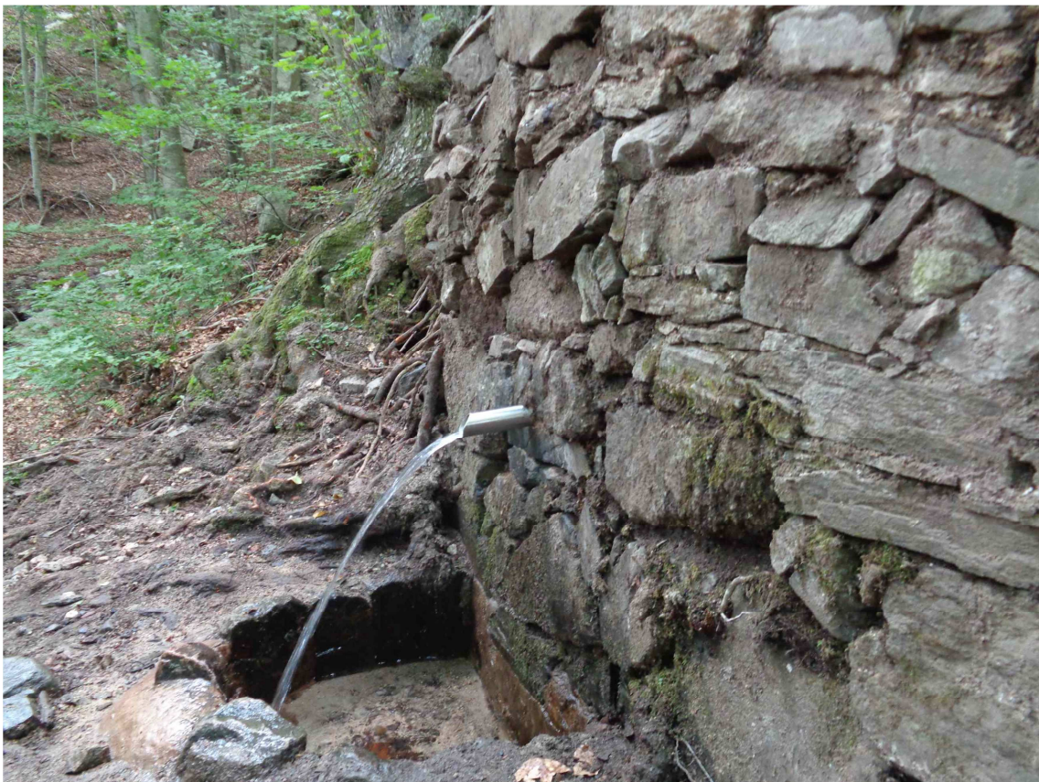
Detall del broc i de les milleres de la font (foto O. Farrerons)
