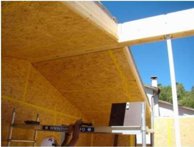
Figura 4.09: Montaje de cubierta (Fuente: Progetic)
