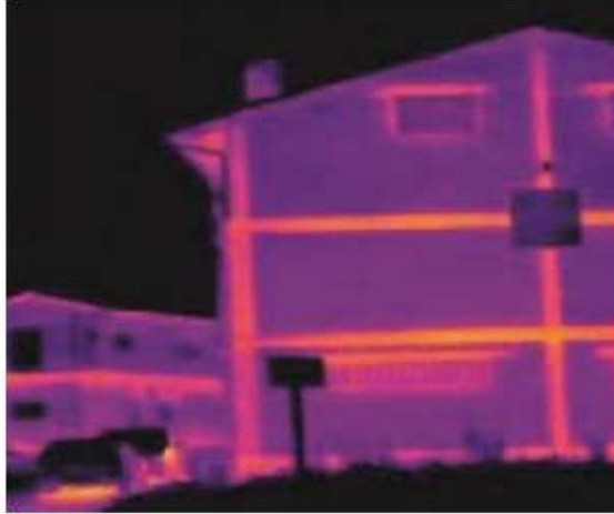
Figura 1.10: Puentes térmicos en una edificación (Fuente: Google)
