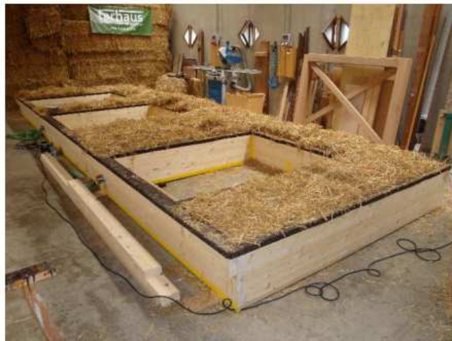
Figura 4.08: Montaje de fachada (Fuente:Farhaus)
