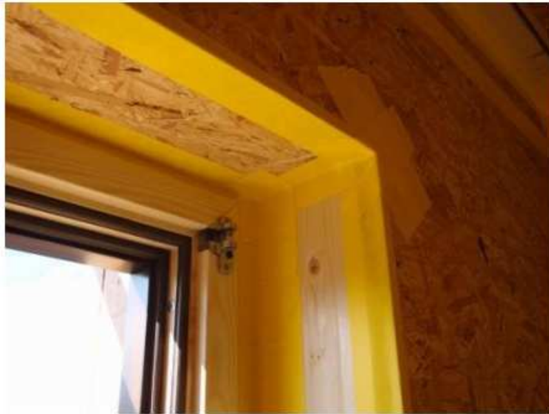
Figura 4.10: Detalle unión tableros (Fuente :Progetic)
