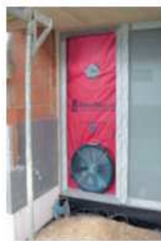
Figura 1.14: Test Blower Door (Fuente: Energiehaus)
