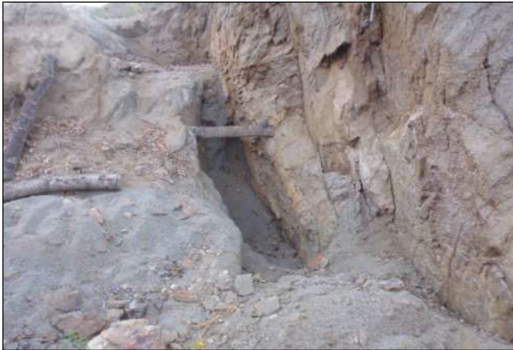
Figura 74: Beta auxiliar la cual se ubica en el flanco izquierdo del frente de la cuenca. BETA DE 20 gr.
