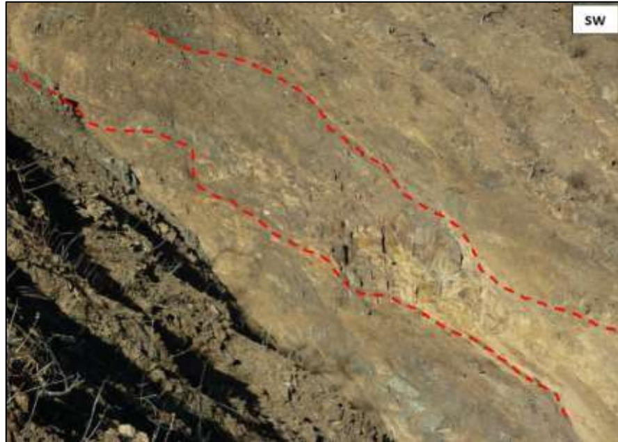
Figura 28: Estructura presente caracterizada como una brecha tipo crack y con abundante presencia de óxidos férricos. Las líneas punteadas indican el posible contacto de la brecha con el macizo rocoso.
