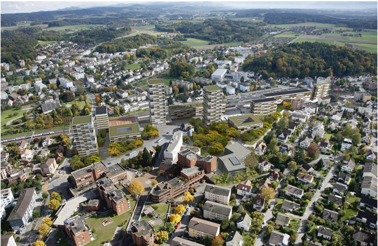
Abb. 2 Effretikon mit neuem Zentrum. Fotomontage mit Hochbauten und Stadtgärten. (Quelle: Stadt Illnau-Effretikon)
