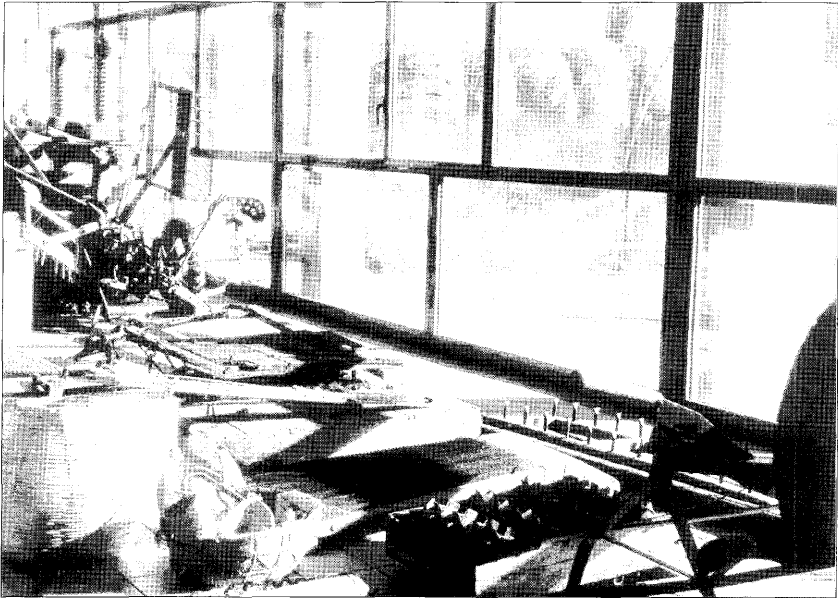
Figura 5. Perspectiva de las nuevas instalaciones durante el periodo de montaje (año 2001).
