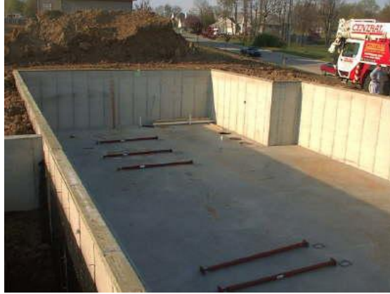
Figura 2.6: Construção de cave: as paredes servirão de suporte à estrutura da casa modular.
