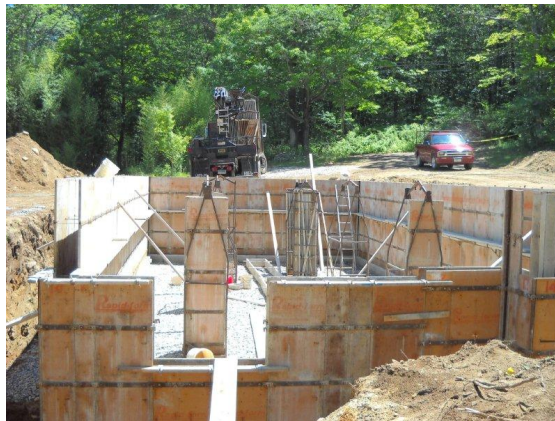
Figura 2.7: Construção de cave: moldes de madeira para vazamento do betão.
