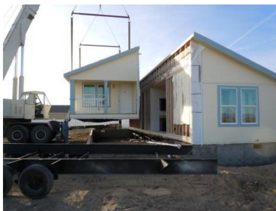
Figura 2.8: Posicionamento de módulo sobre fundação de betão.
