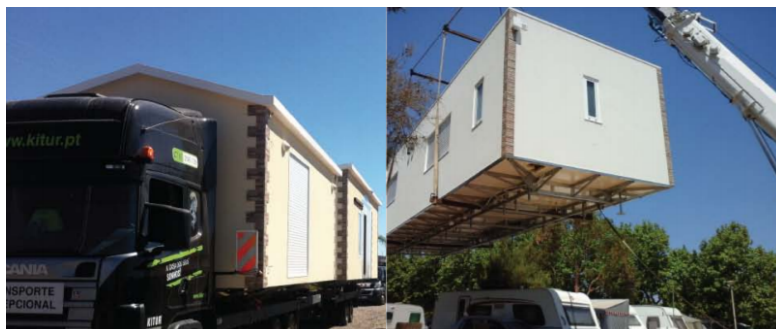
Figura 2.12: Transporte e montagem de uma casa KITUR. [6]
