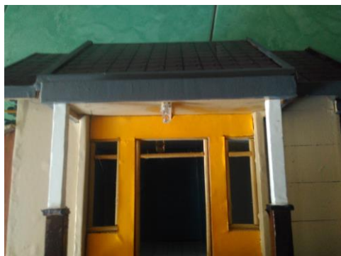
Gambar 9. Pemasangan Lampu Led
