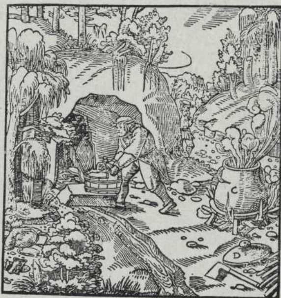
Fig. 9 A. Pou de betum; B. Cub; C. Olla; D. Tapadora. Recollint petroli d'un pou i bullint-lo en una olla de bronze o de ferro, segons Georgius AGRICOLA, en la seva "De Re Metallica", 1556
