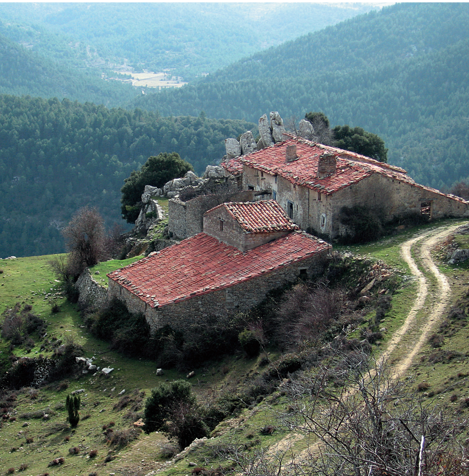
Els masos abandonats formen part dels paisatges que s'observen des dels diversos camins de muntanya de les comarques de l'interior. A la imatge, mas d'en Roda i camí d'accés. La Tinença de Benifassà (Baix Maestrat).
