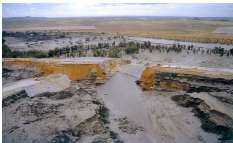
Foto 1: Rotura de la balsa de contención (Consejería de Medio Ambiente, 1998)
