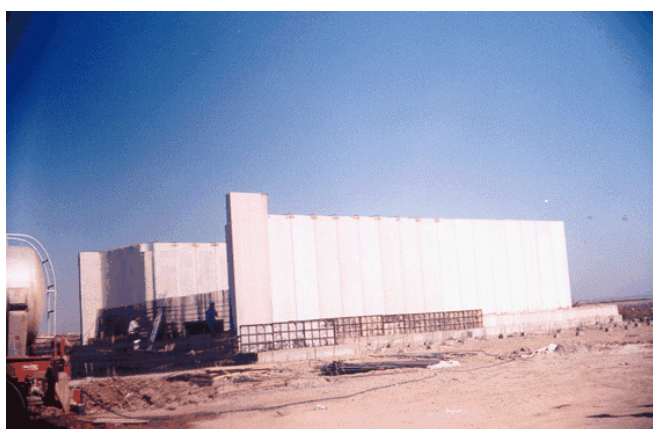
Foto 4: Planta depuradora el 23 de Julio de 1998.
