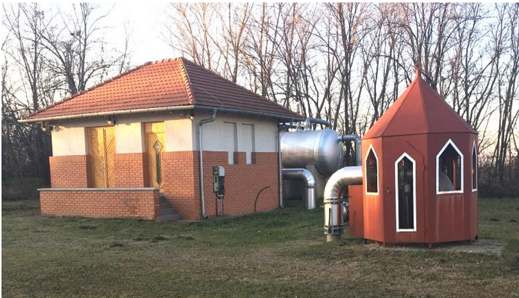
7. ábra: K-23-as számú visszasajtoló kút, amely a fenntarthatóbb üzemeltetésről gondoskodik (saját felvétel)
