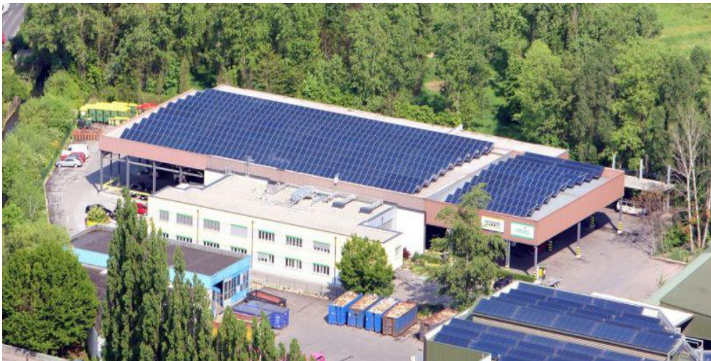
6. ábra: A gráci ipari létesítmények tetejére helyezett napkollektorok (forrás: SOLAR HEAT EUROPE 2017)
