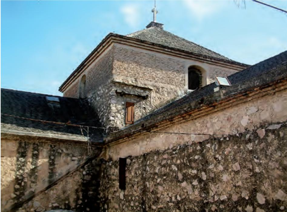
Fig. 4. Detalle de la canaleta que quedó donde encastraba el techo original.
