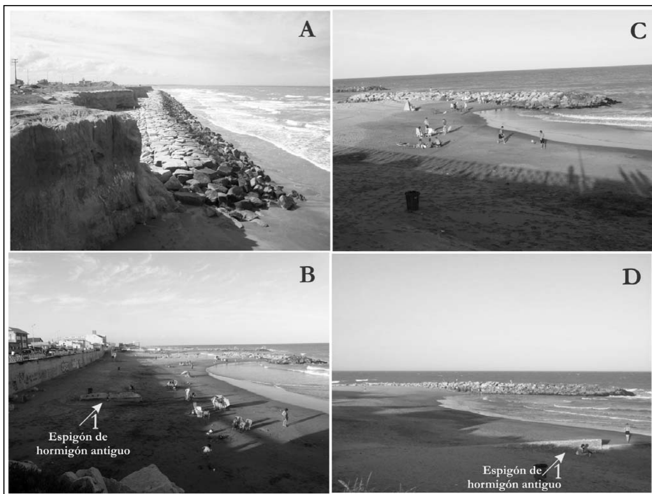
Figura 6. A: Se observa un montículo de bloques dispuesto a lo largo de la costa al sur de Santa Clara del Mar; B: paredón vertical ( seawall ) contra el antiguo acantilado a la izquierda de la fotografía; C: detalle de espigón en 'T'; D: antiguo espigón de hormigón sobre la playa al frente (1) y espigón de cuarcita actual por detrás tanto en B como en D.
