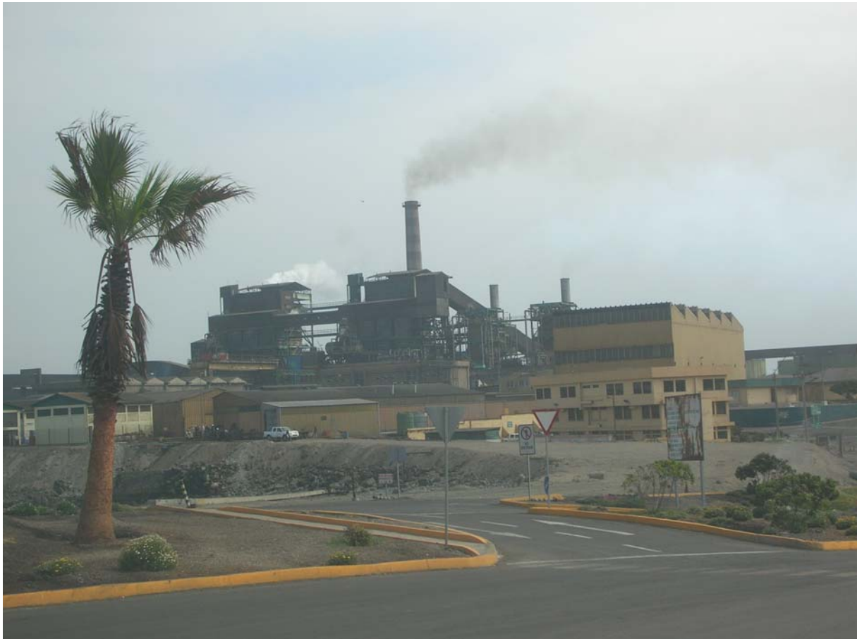
Photo N° 4 : Centrale thermique à charbon Norgener à Tocopilla.
