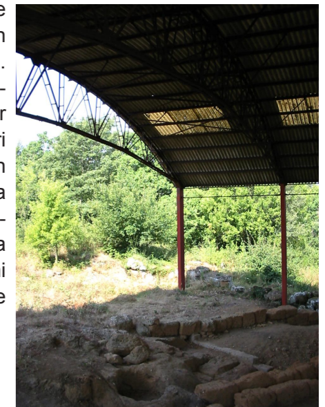
Due viste della struttura di copertura dall'interno; il manto della chiusura superiore, su esile struttura metallica, è composto da lastre in materiale plastico opache e traslucide limitatamente alle due fasce laterali del manto, probabilmente per aumentare l'effetto di diffusione luminosa sui reperti archeologici protetti
