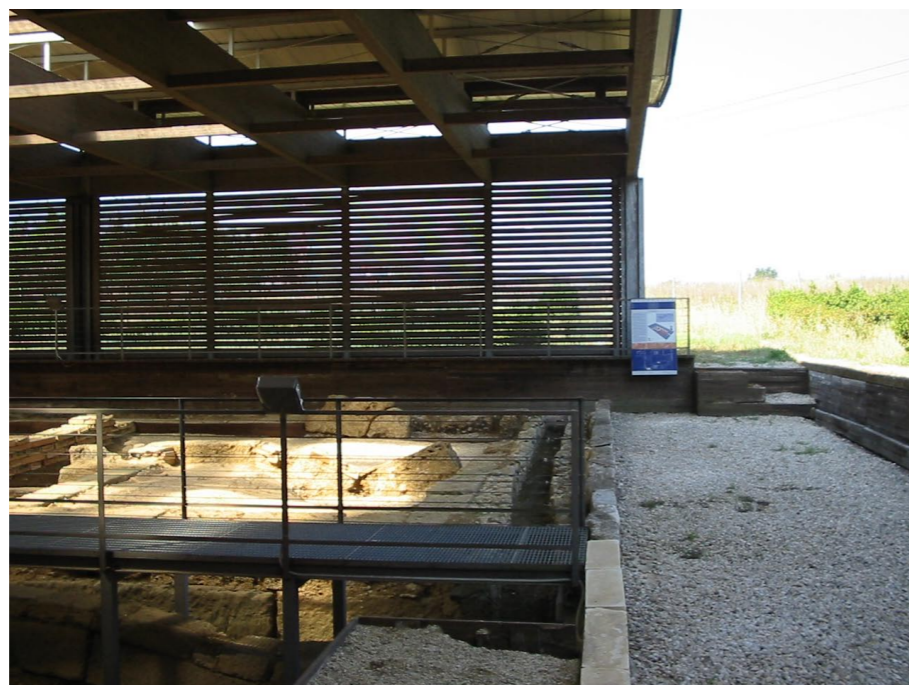
Vista della chiusura verticale a listelli di legno e dell'effetto luminoso dell'impluvium trasparente
