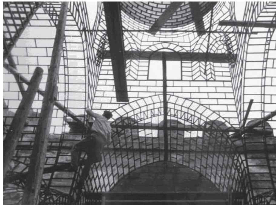
Vista dall'interno dell'intervento di integrazione in perspex della chiesa di San Nicolò Regale a Mazara del Vallo
