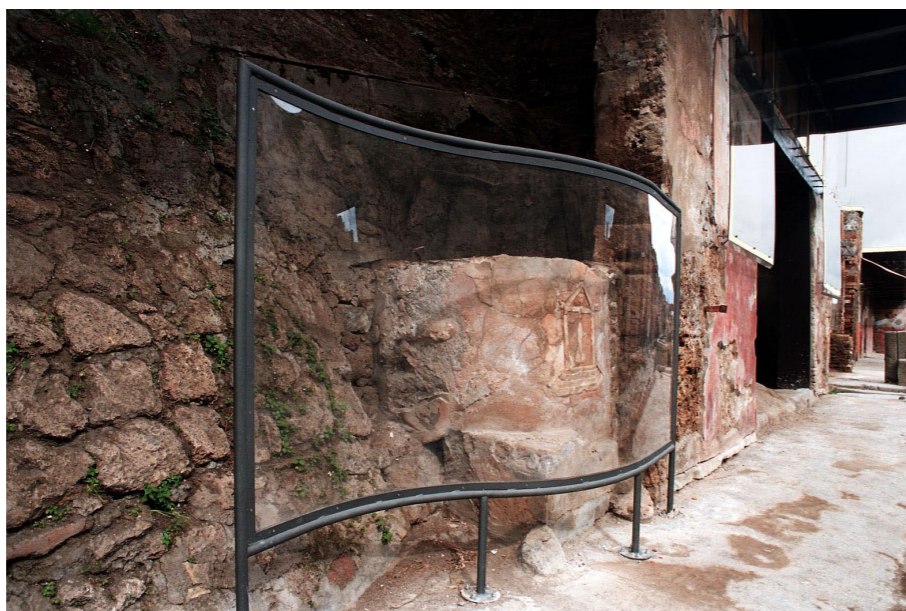
In alto e a destra, viste della lastra in polycarbonato trasparente sagomata a protezione della caldaia
