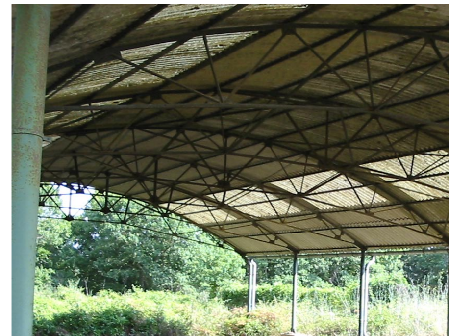
Due viste della struttura di copertura dall'interno; il manto della chiusura superiore, su esile struttura metallica, è composto da lastre in materiale plastico opache e traslucide limitatamente alle due fasce laterali del manto, probabilmente per aumentare l'effetto di diffusione luminosa sui reperti archeologici protetti
