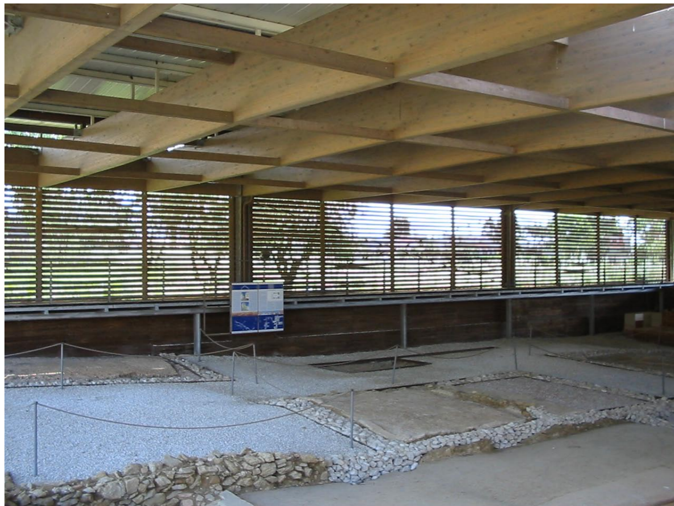
Vista interna della domus al completamento del progetto di protezione e riconfigurazione e dettaglio della struttura di copertura con l'effetto luminoso affidato alla riproposizione del displuvio
