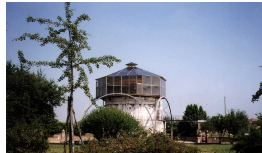
Struttura provvisoria per il restauro del monolite di copertura del Mausoleo di Teodorico, Ravenna. Per consentire la percezione del monumento e dei lavori, per le chiusure verticali e il manto di copertura sono stati utilizzati pannelli in policarbonato trasparente ma di coloritura bronzea per ridurre la trasmissione termica
