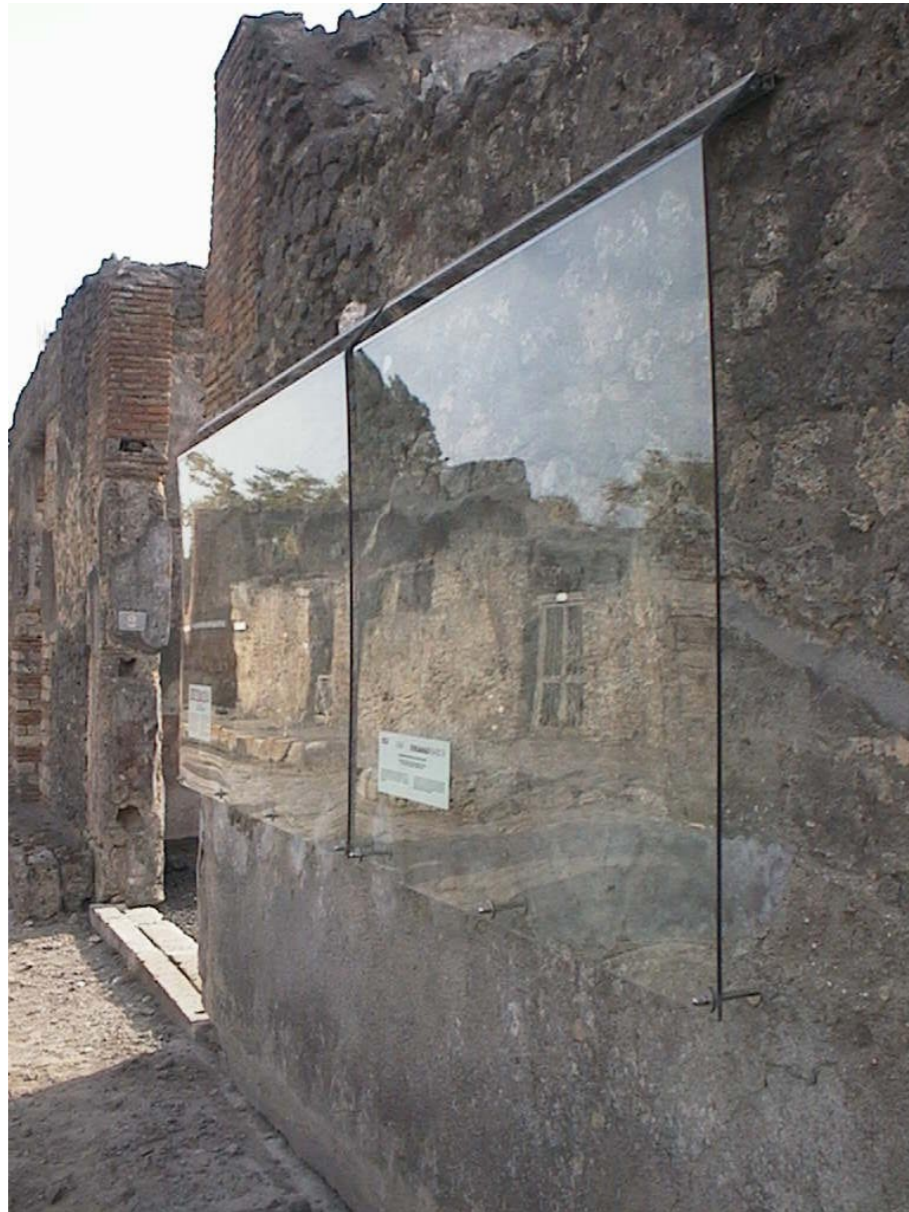
Due lastre di polycarbonato compatto trasparente a protezione di due dipinti murali sulla muratura esterna dell'Insula lungo la via di Nola
