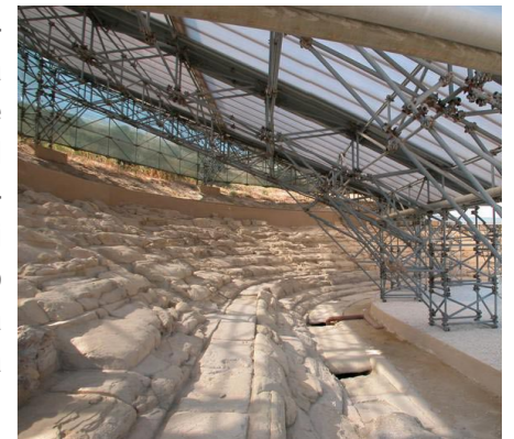
Vista complessiva e dettaglio interno della copertura provvisoria realizzata a protezione del teatro a seguito della rimozione delle sagome di materiale plastico
