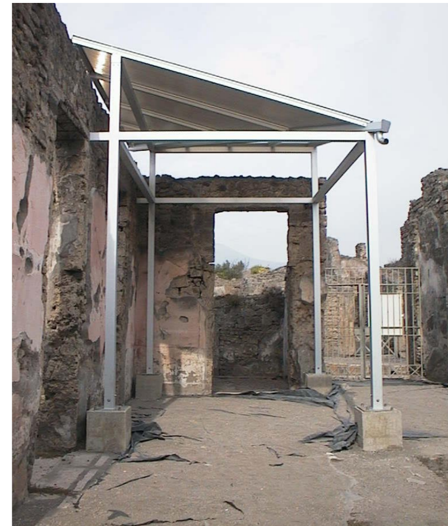
Vista dall'interno della copertura realizzata nell'angolo dell'atrio principale della Casa del Centenario
