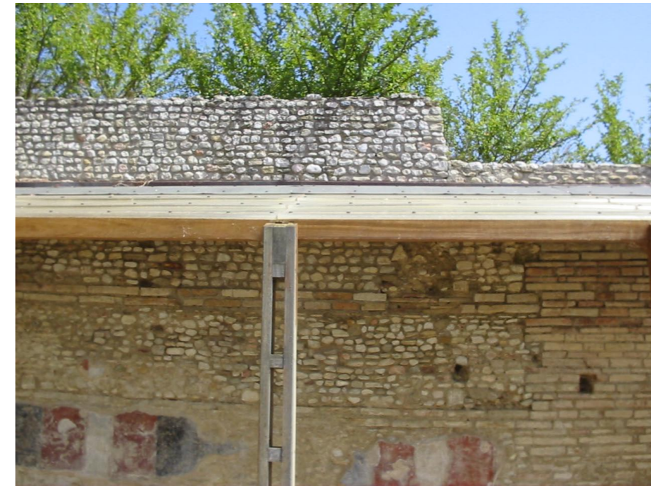
Dettagli della copertura a tettoia a protezione delle pitture murali sulle murature esterne del teatro. Sono visibili i pilastri prefabbricati in c.a. e l'incastro della trave alla muratura
