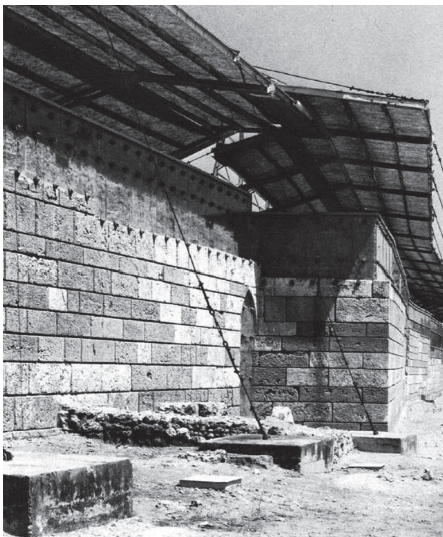
Mura greche di Capo Soprano, Gela. Vista del sistema di protezione ad opera di Franco Minissi
