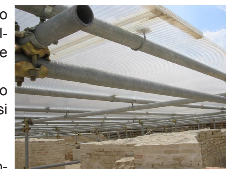
Tubi innocenti e lastre alveolari trasparenti fissate con ganci metallici costituiscono la copertura del sito archeologico di Sassocorvaro, Ancona
