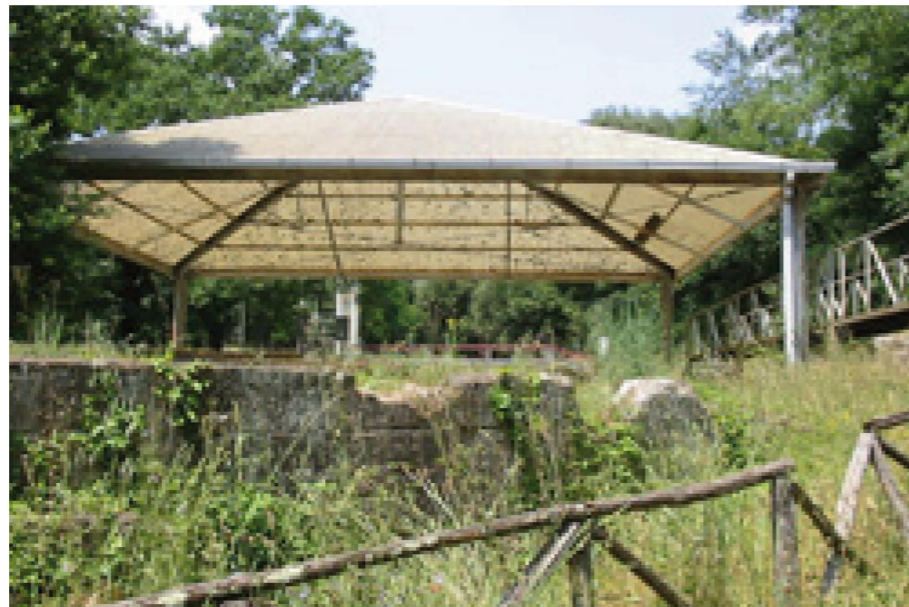
Vista dall'esterno della copertura dei resti dell'altare
