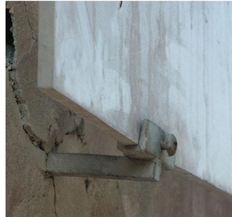
Dettaglio di un sistema di aggancio applicato negli anni Sessanta ad una muratura storica del sito di Pompei a sostegno di una lastra in vetro. Il dispositivo è irremovibile a meno di causare la perdita di una consistente parte della muratura originale
