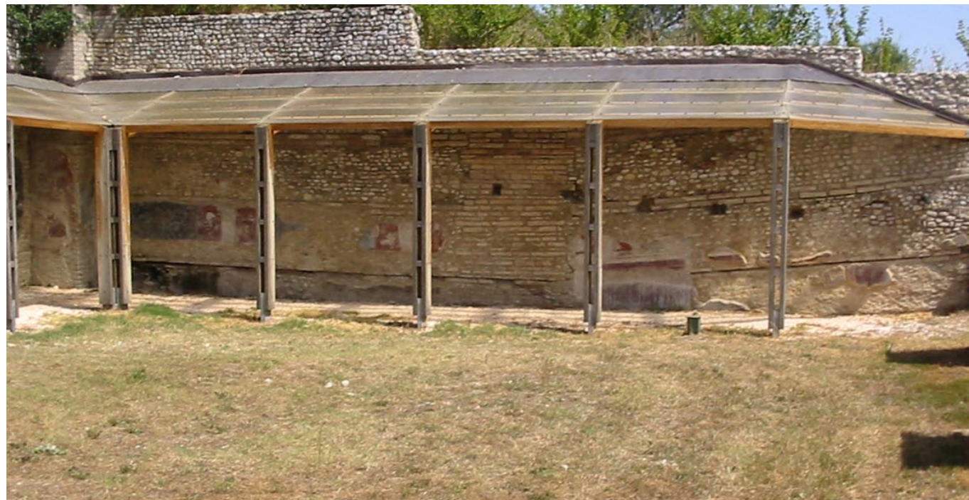
Vista della copertura a tettoia addossata alle strutture del teatro a protezione dei lacerti di pitture murali
