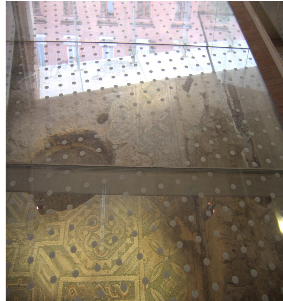
Dettagli dell'edificio progettato a protezione e valorizzazione della Domus del Chirurgo, Rimini; passerelle e chiusure verticali in vetro non facilitano la visibilità nè dall'esterno nè all'interno
