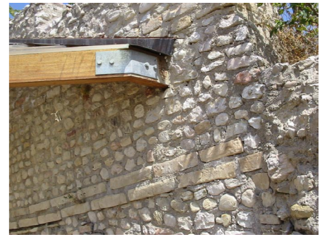
Vista della zona sottostante la tettoia; sono visibili i pannelli in materiale plastico traslucido che costituiscono il manto di chiusura superiore e i lacerti delle pitture murali
