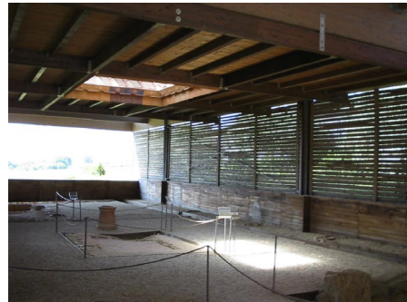
Vista interna della domus una volta completato il restauro, il progetto di copertura e l'allestimento museale. La creazione dell'effetto di luce che proveniva dall'impluvium è affidato a lastre trasparenti in policarbonato poste sulla copertura
