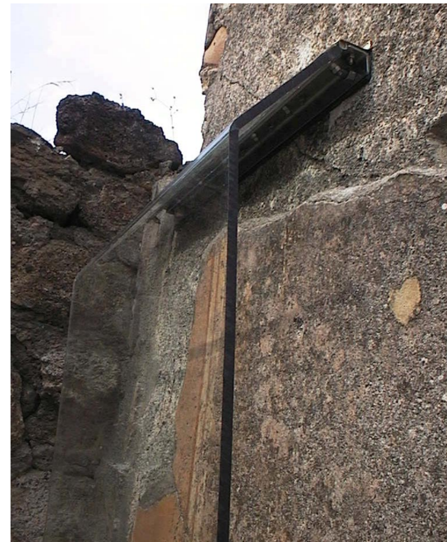
Lastre applicate in contesto archeologico a protezione di un lacerto di dipinto murale; la piegatura superiore consente lo scivolamento delle acque meteoriche e la cerniera consente il monitoraggio di dispositive e pittura murale
