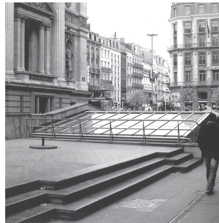
Sopra e in alto a destra, Museo Bruxella 1238, Bruxelles, dove la struttura interamente vetrata a protezione di un convento francescano del XIII secolo subisce il riflesso che non consente di vedere ciò che in realtà la struttura protettiva invita a guardare
