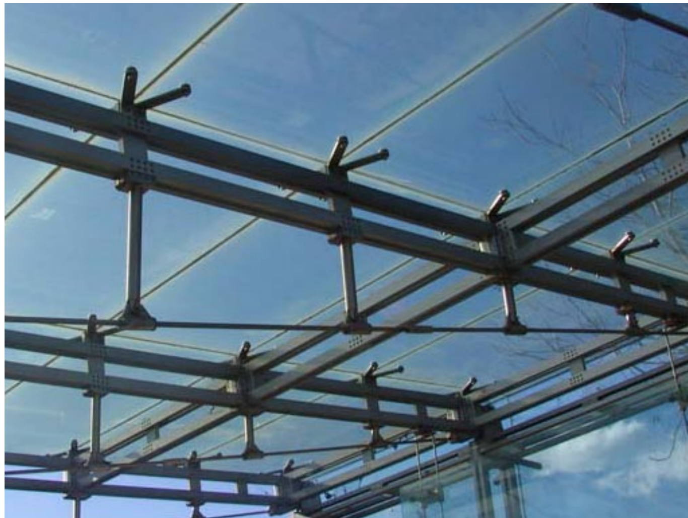
Dettaglio della chiusura orizzontale a protezione dei resti scavati. La copertura è a una falda con lastre di vetro strutturale sigillate tra loro
