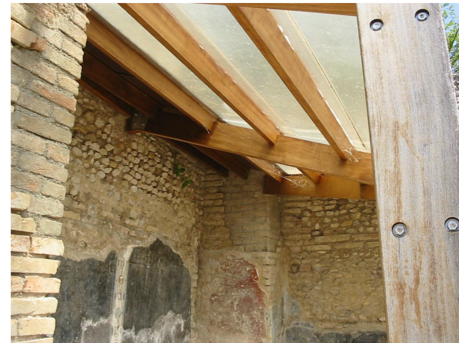
Vista della zona sottostante la tettoia; sono visibili i pannelli in materiale plastico traslucido che costituiscono il manto di chiusura superiore e i lacerti delle pitture murali
