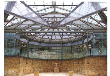
La grande copertura trasparente e le passerelle ancorate tramite tubolari metallici alla muratura di sacrificio realizzata sopra i resti delle strutture murarie antiche
