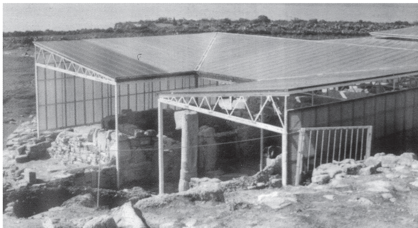
Strutture permanenti di copertura nel sito archeologico di Eraclea Minoa
