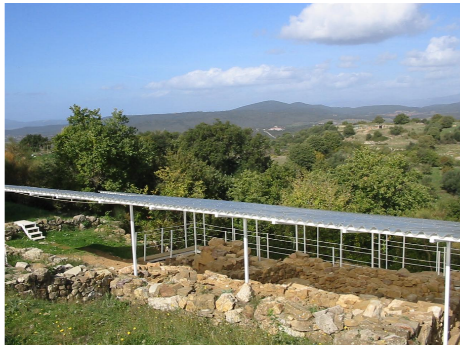
Vista della copertura dell'area del foro; oltre alla "tettoia" con manto di copertura in lastre ondulate di materiale plastico completamente trasparenti per ridurre l'impatto percettivo della struttura, è visibile la passerella che guida il percorso di vista esternamente ai resti protetti
