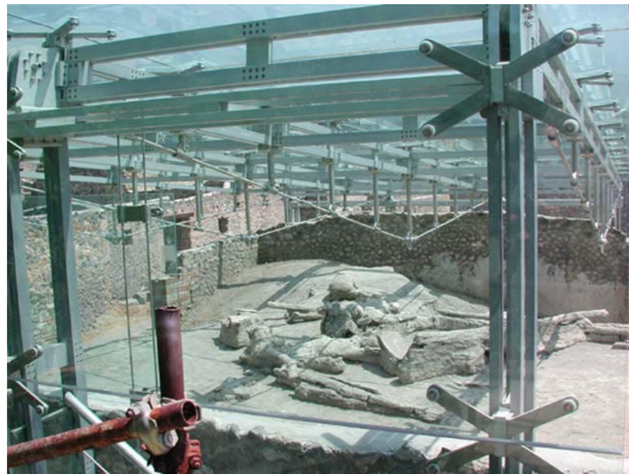
Vista all'interno del prototipo di copertura trasparente posta in opera nel sito, attraverso la chiusura verticale
