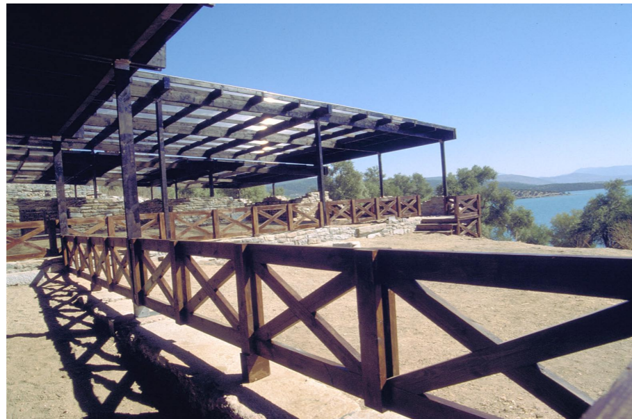
Vista della struttura di copertura in legno e manto di pannelli trasparenti in polycarbonato
