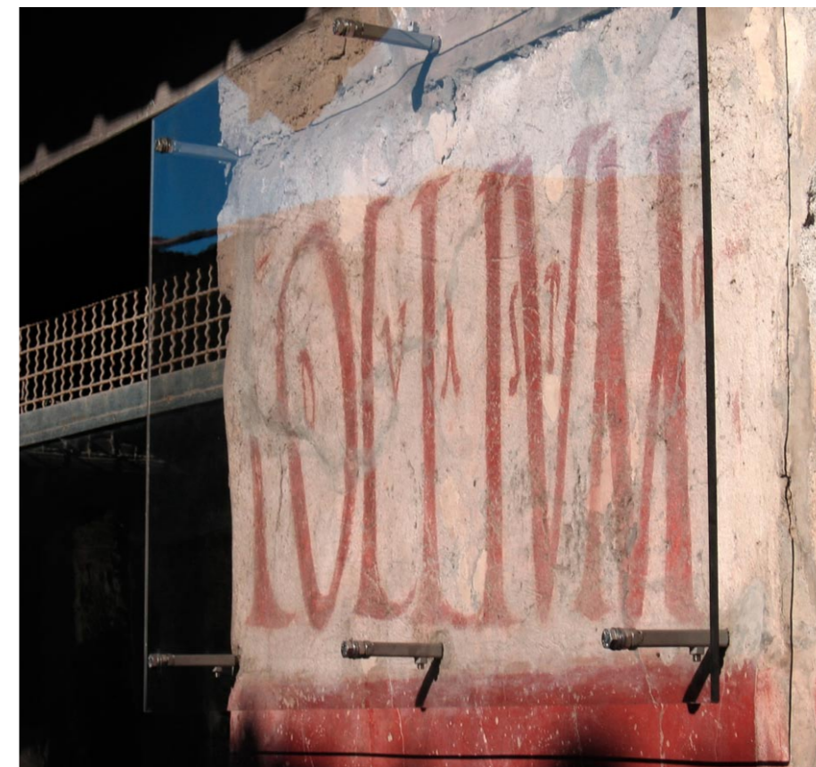
Lastra in policarbonato trasparente collocata a protezione di una iscrizione elettorale, sito archeologico di Pompei; la lastra sfrutta gli agganci preesistenti, non removibili
