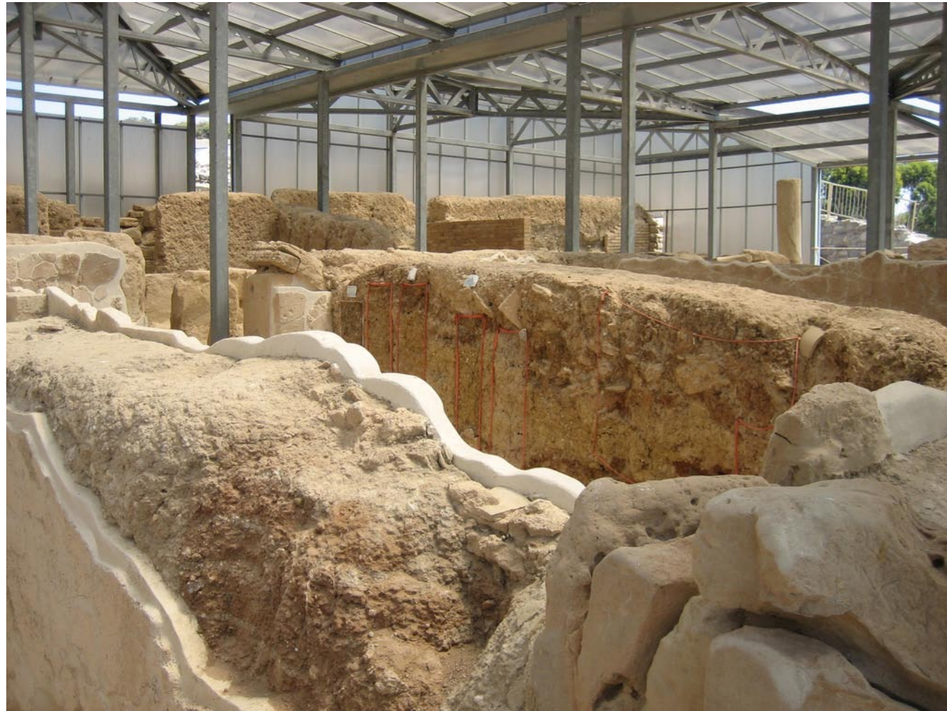
Vista interna dell'antica abitazione nel sito archeologico di Eraclea Minoa protetta dalla struttura di copertura intelaiata in acciaio e con manto di copertura e chiusure verticali in pannelli traslucidi alveolari di PVC, finalizzata alla protezione e al suggerimento delle antiche volumetrie
