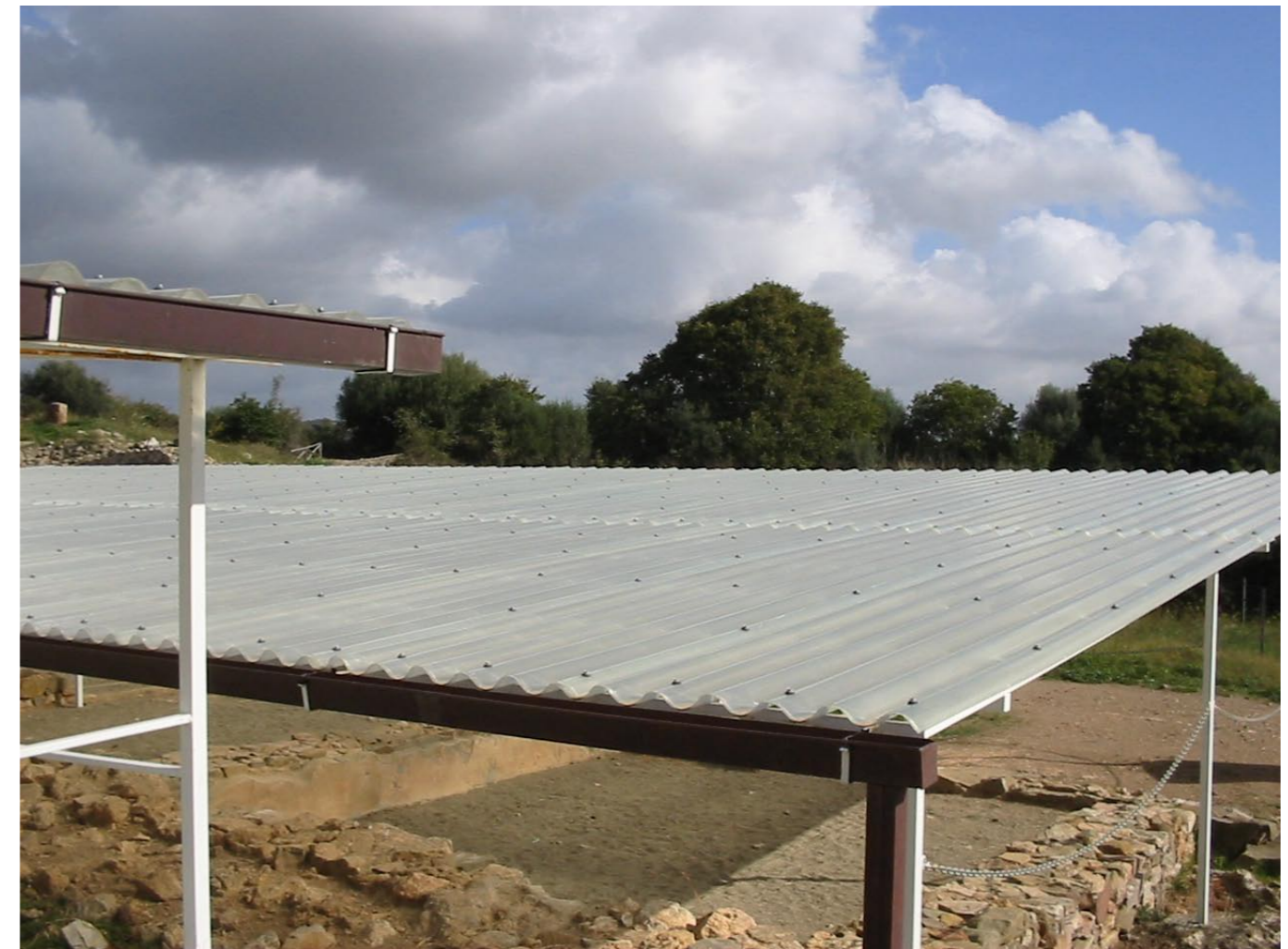
Dettaglio del manto di copertura della tettoia a protezione della casa adiacente l'anfiteatro
