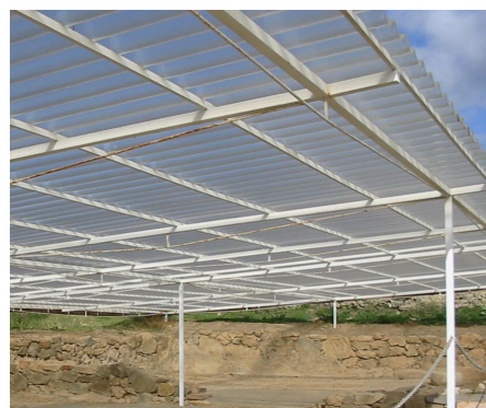
Lastre ondulate trasparenti utilizzate come manto di copertura nel sito archeologico di Roselle, Grosseto
