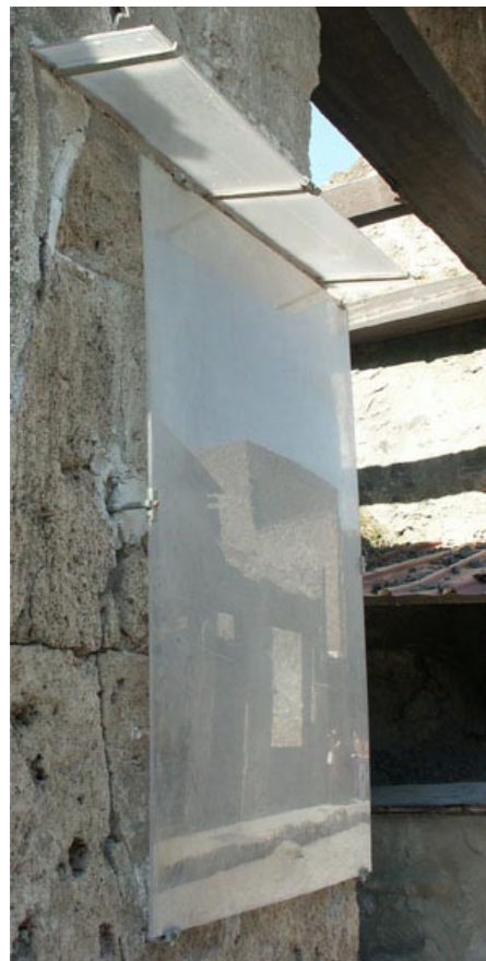
Dettaglio delle lastre in plexiglass collocate sui dipinti murali prima dell'avvio del cantiere di restauro
