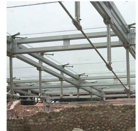
Sopra, dettaglio della chiusura superiore trasparente; sotto, la scala che consente di vedere i resti dall'alto
