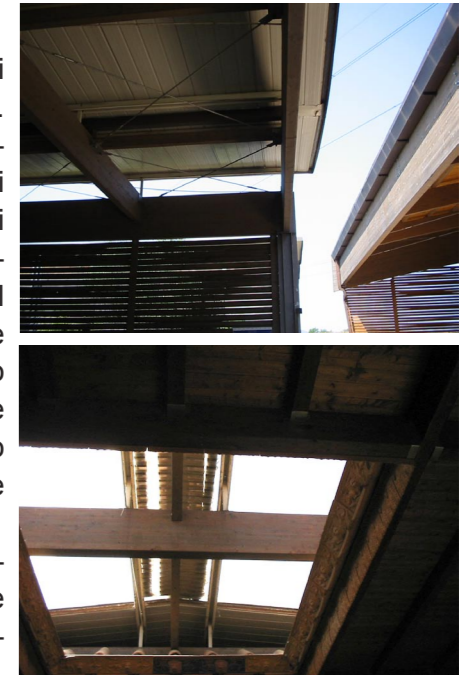
Due dettagli delle lastre trasparenti in policarbonato utilizzate in copertura per ricreare l'effetto che aveva la luce proveniente dal displuvium
