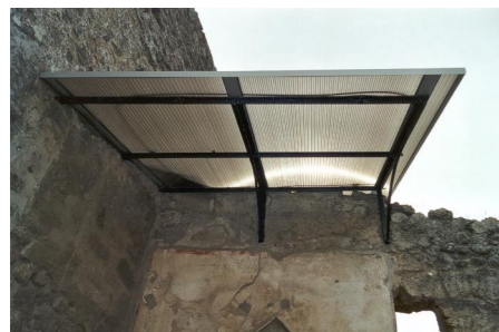
Lastra alveolare traslucida in policarbonato montata mediante un leggero telaio sulla muratura storica di sacrificio, in sommità, per proteggere il lacerto di pittura murale
