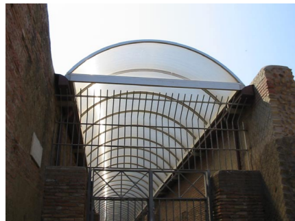
Tunnel trasparente in policarbonato a protezione della "galleria lapidaria", Ostia antica
