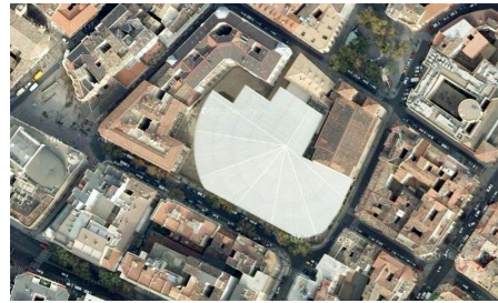
Vista aerea dell'estensione della copertura
