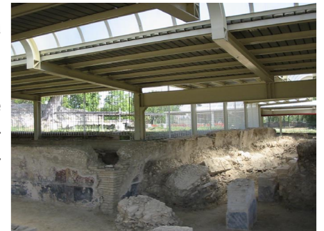
Viste interne della copertura del portico; oltre al tunnel centrale al manto di copertura, l'illuminazione deriva da tre lati privi di chiusure verticali
