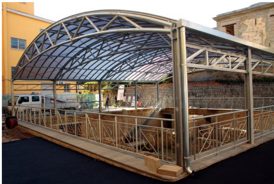
Vista esterna complessiva della struttura di copertura a protezione dei resti dell'antico foro, posti ad una quota inferiore rispetto a quella stradale
