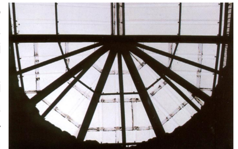
Vista della struttura di copertura
