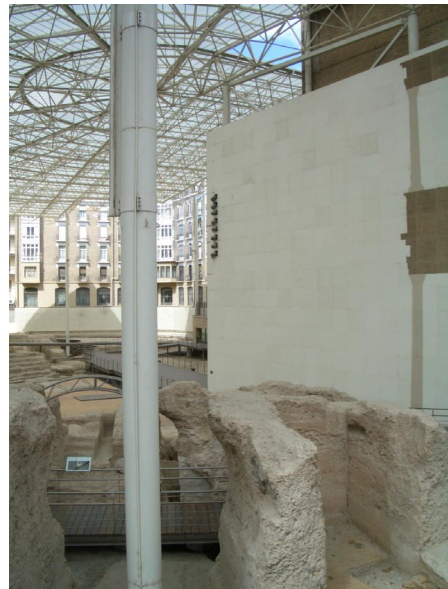
Vista della copertura dal basso e dell'effetto luminoso conferito dai pannelli di polycarbonato traslucidi
