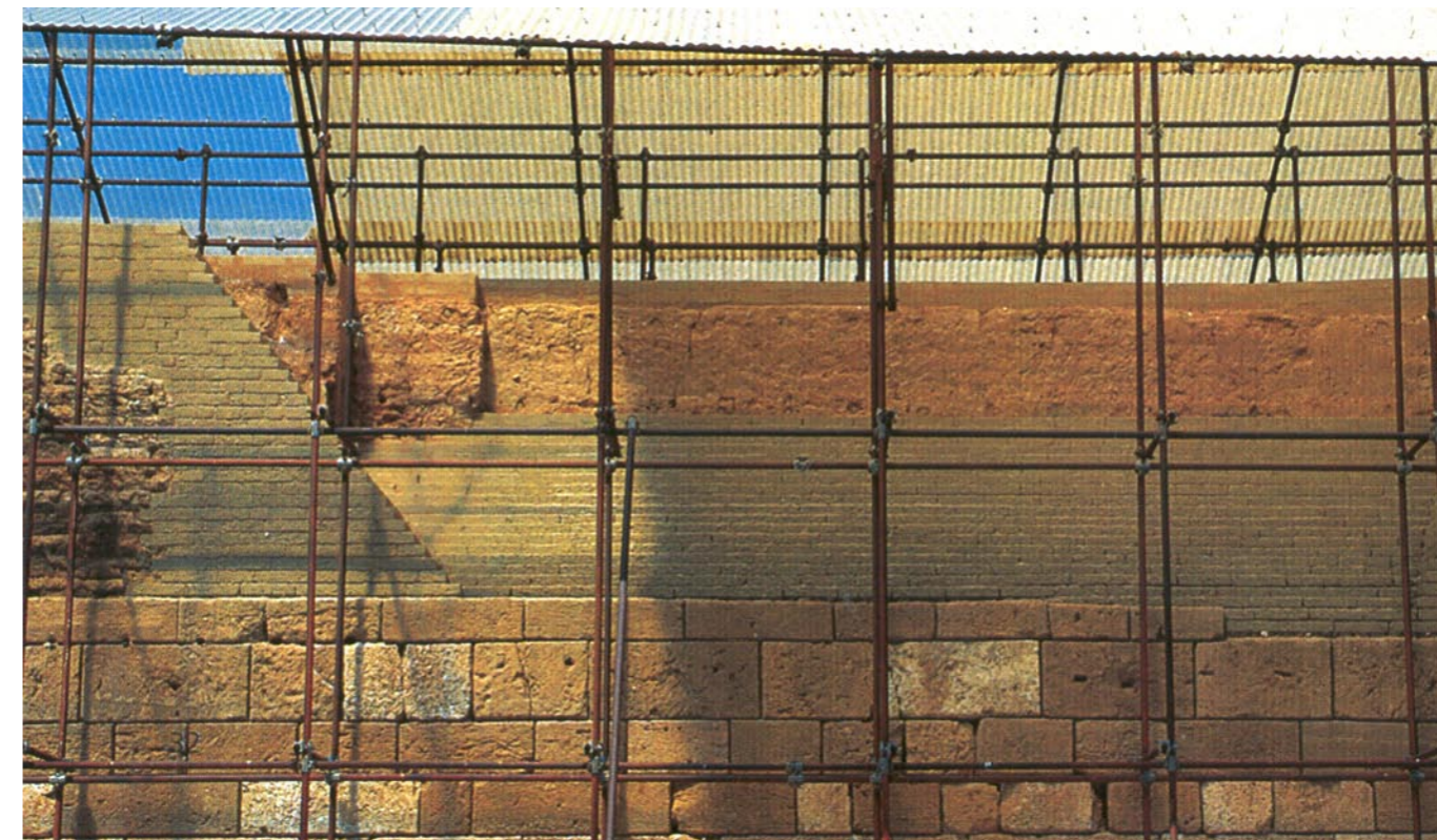
Vista generale della tettoia collocata sopra alle mura a seguito della rimozione dell'intervento di Minissi. Sopra, tessiture murarie di epoche diverse e recenti consolidamenti in terra cruda
