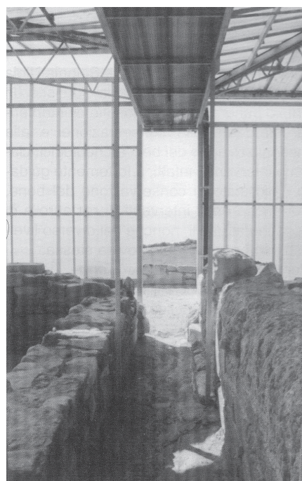
Pannelli alveolari traslucidi in PVC costituiscono le chiusure verticali della struttura a protezione di due antiche abitazioni nel sito archeologico di Eraclea Minoa
