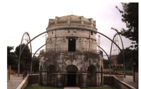
Struttura provvisoria per il restauro del monolite di copertura del Mausoleo di Teodorico, Ravenna. Per consentire la percezione del monumento e dei lavori, per le chiusure verticali e il manto di copertura sono stati utilizzati pannelli in policarbonato trasparente ma di coloritura bronzea per ridurre la trasmissione termica
