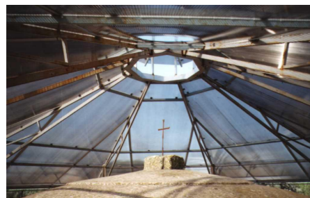
Struttura provvisoria in policarbonato trasparente per il restauro del monolite di copertura del Mausoleo di Teodorico, Ravenna.
