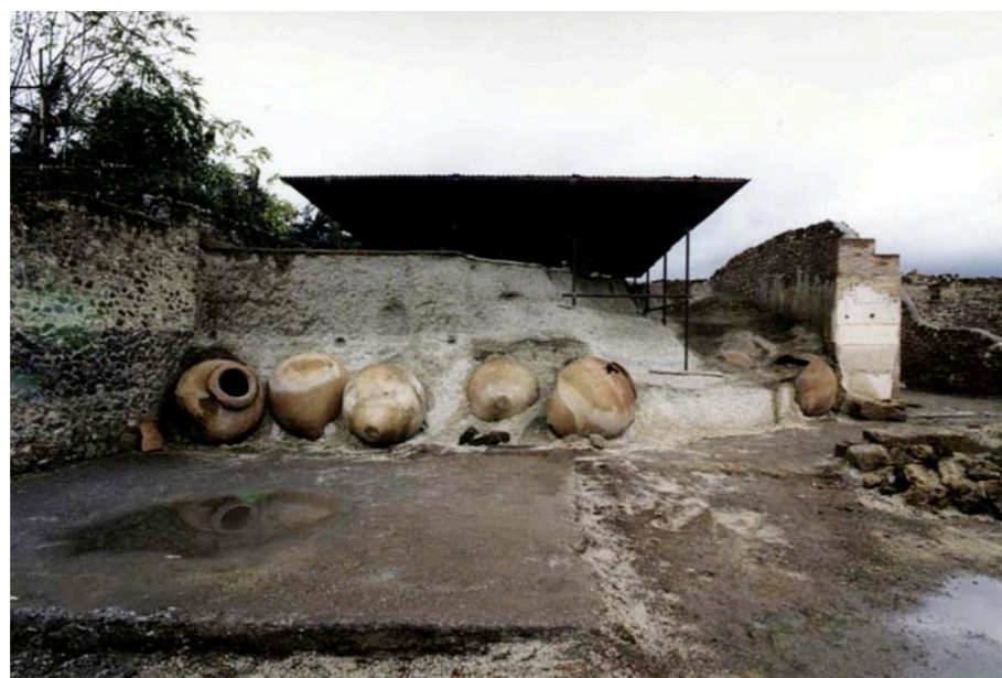
Vista della struttura provvisoria di copertura che proteggeva i resti dell'Orto dei fuggiaschi prima del montaggio del prototipo di copertura trasparente
