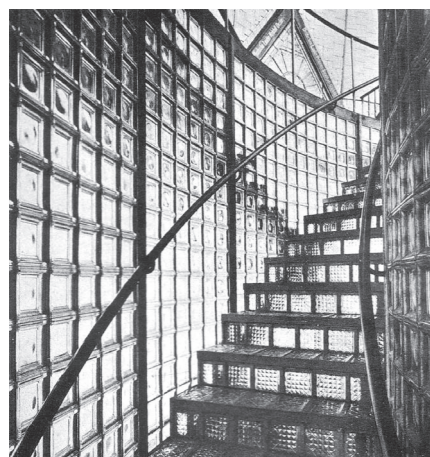
Bruno Taut, Glashaus, padiglione di vetro per l'esposizione del Deutscher Werkbund, Colonia 1914, vista esterna e interna. La scala, le pareti e la copertura interamente vetrate, al di là della forte motivazione simbolica, dimostrano le potenzialità offerte dall'industria del vetro al settore delle costruzioni
