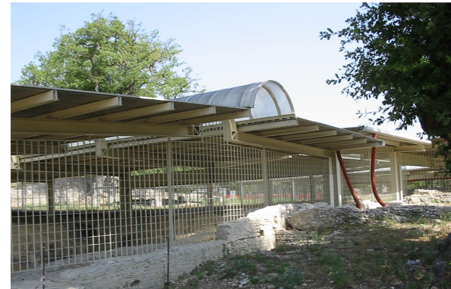
Vista della copertura del tempio dall'esterno, con la grata metallica posta a protezione da intrusioni e atti vandalici
