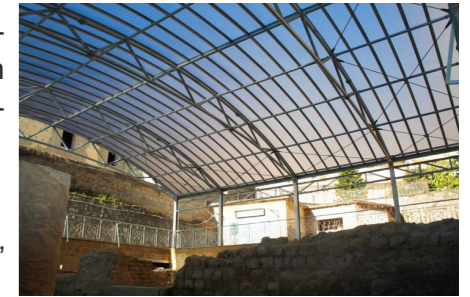
Vista dell'intradosso della copertura; il manto è in lastre compatte traslucide di policarbonato
