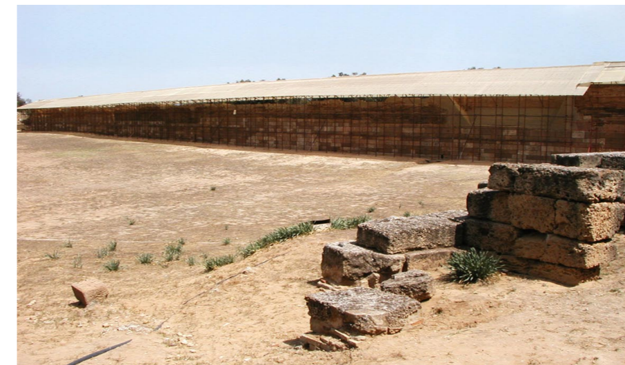
Vista generale della tettoia collocata sopra alle mura a seguito della rimozione dell'intervento di Minissi. Sopra, tessiture murarie di epoche diverse e recenti consolidamenti in terra cruda
