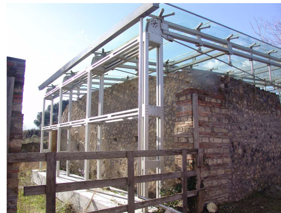
Vista esterna del prototipo di copertura trasparente per l'Orto dei fuggiaschi con struttura in acciaio e alluminio e vetro strutturale
