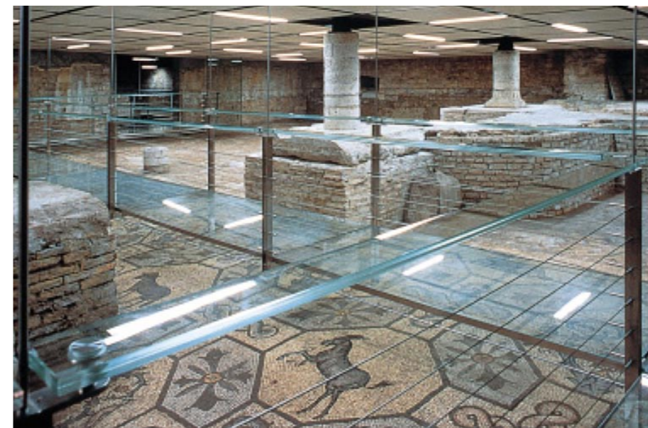
Passerella in vetro nella basilica di Aquileia nel progetto di valorizzazione della pavimentazione musiva
