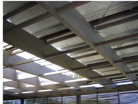
Vista interna della domus al completamento del progetto di protezione e riconfigurazione e dettaglio della struttura di copertura con l'effetto luminoso affidato alla riproposizione del displuvio
