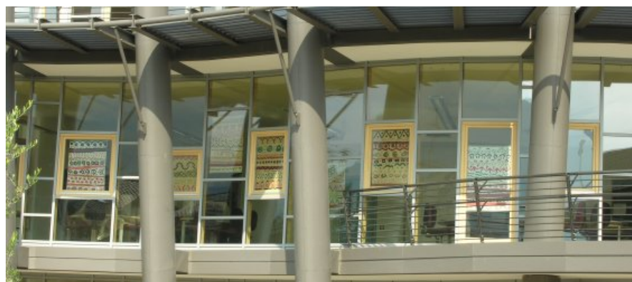
Fig. 191 Progetto: vista esterna delle facciate strutturali in vetro della parte nuova.
