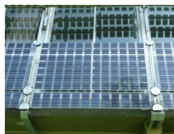
Fig. 463 Istituto Professionale per l'Industria e l'Artigianato, Rovigo – ing. Luigi Ferrari (Provincia di Rovigo). Moduli semitrasparenti fissi a celle fitte.
