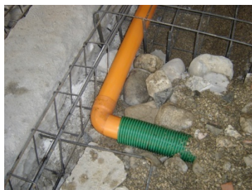
Fig. 380 Scuola primaria a Fonzaso – loc. Arten (BL). Posa in opera del tubo forato all'interno del sottofondo (Foto: prof. G. Zannoni).
