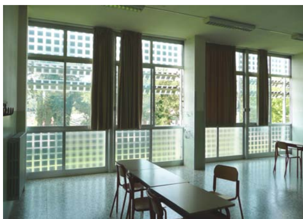
Fig. 251 Aula tipo per la didattica. Le tende interne sono una rimanenza della precedente configurazione senza moduli fotovoltaici in cui era necessario proteggere le aule dall'irraggiamento solare diretto.
