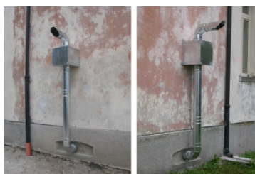
Fig. 386 Scuola primaria "Gino Allegri" a Feltre – loc. Foen (BL). Impianto di aspirazione a singolo tubo (Foto: prof. G. Zannoni).
