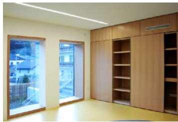
Fig. 412 Scuola per l'infanzia di Monguelfo (BZ) – EM2 Architetti. Elementi di arredo per l'alloggiamento del dispositivo di ventilazione (Foto: EM2 Architetti).
