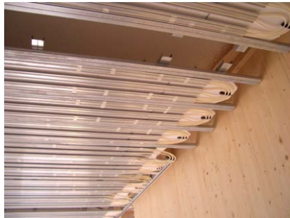
Fig. 130 Progetto: sistema di riscaldamento a soffitto radiante del nuovo volume (immagine delle fasi di cantiere)
