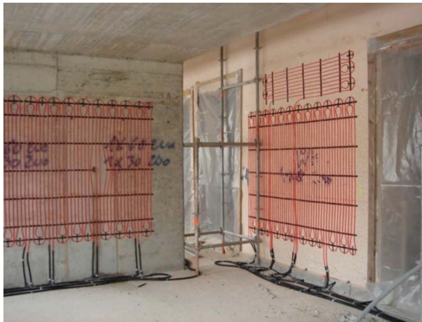
Fig. 129 Progetto: sistema di pareti radianti delle aule (immagine della fase di cantiere).
