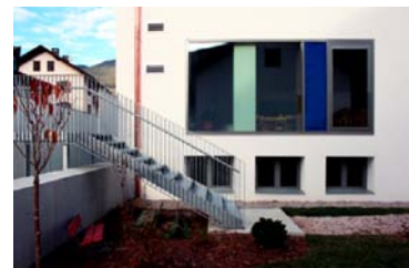
Fig. 422 Scuola per l'infanzia di Monguelfo (BZ) – EM2 Architetti. Griglie esterne di ventilazione in ingresso e in uscita (Foto: EM2 Architetti).
