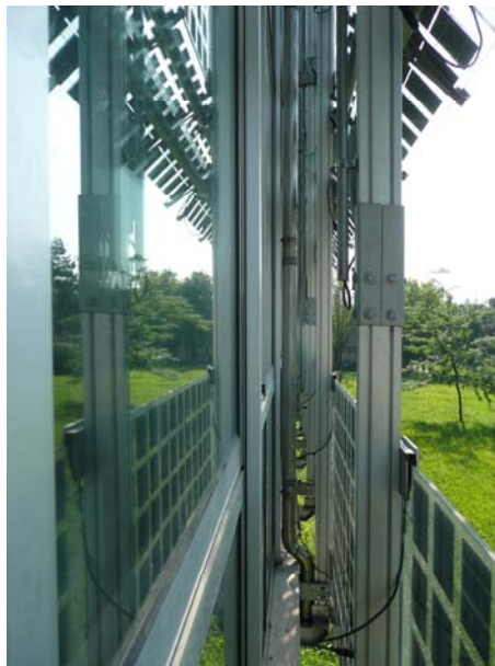
Fig. 249 Particolare della doppia pelle fotovoltaica.
