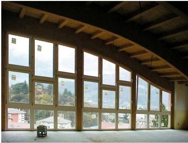
Fig. 141 Progetto: finestre delle sezioni (fase di cantiere).
