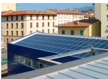
Fig. 465 Scuola per l'infanzia e primaria "Marconi", Firenze – ing. Lorenzo Boganini (Comune di Firenze). Integrazione in copertura di moduli fotovoltaici standard (Foto: Comune di Firenze).
