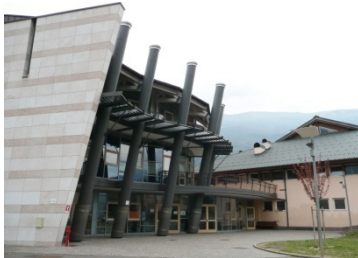
Fig. 449 Scuola primaria, Marco di Rovereto (TN) – arch. Gianluca Perottoni. Le ampie vetrate sono protette da un doppio sistema costituito da schermature fisse (aggetti) e da filtri solari fissi orizzontali.
