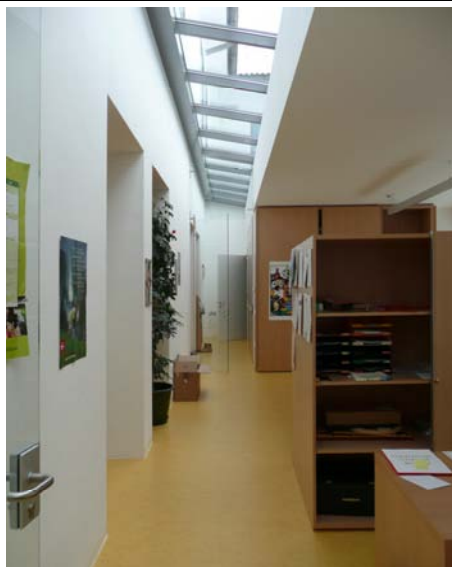
Fig. 128 Progetto: finestra a nastro zenitale del nuovo volume.
