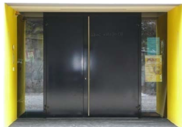
Fig. 396 Scuola primaria, Casteldarne (BZ) – EM2 Architetti. L'ingresso è composto da un vestibolo costituito da una doppia porta che riduce l'impatto dell'aria esterna.
