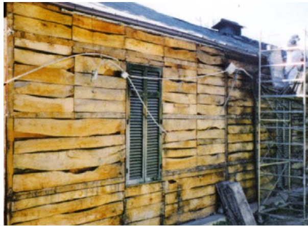
Fig. 202 Fase di cantiere: rimozione del rivestimento in amianto.
