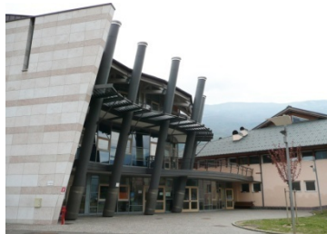
Fig. 441 Scuola primaria, Marco di Rovereto (TN) – arch. Gianluca Perottoni. Le ampie vetrate sono protette da un doppio sistema costituito da schermature fisse (aggetti) e da filtri solari fissi orizzontali.
