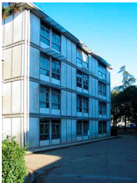
Fig. 213 Edificio esistente: immagine esterna del corpo di fabbrica.
