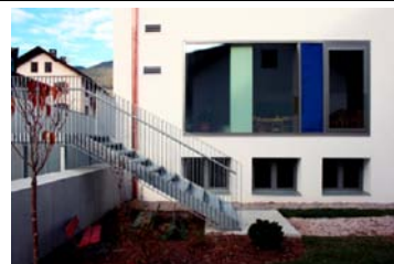
Fig. 389 Scuola per l'infanzia di Monguelfo (BZ) – EM2 Architetti. Griglie esterne di ventilazione in ingresso e in uscita (Foto: EM2 Architetti).
