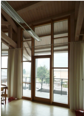
Fig. 439 Scuola primaria, Marco di Rovereto (TN) – arch. Gianluca Perottoni. Posizionamento di schermature interne flessibili a protezione delle ampie chiusure trasparenti.
