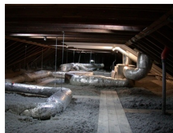
Fig. 402 Istituto Superiore Professionale, Aquisgrana – Comune di Aquisgrana. Coibentazione del sottotetto con fiocchi di cellulosa (Foto: IEA ECBCS – Annex 36).
