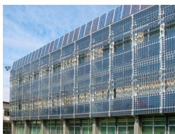
Fig. 461 Istituto Professionale per l'Industria e l'Artigianato, Rovigo – ing. Luigi Ferrari (Provincia di Rovigo). Integrazione di moduli fotovoltaici per la produzione di energia elettrica e per la riduzione del surriscaldamento delle aule dovuto a irraggiamento diretto.
