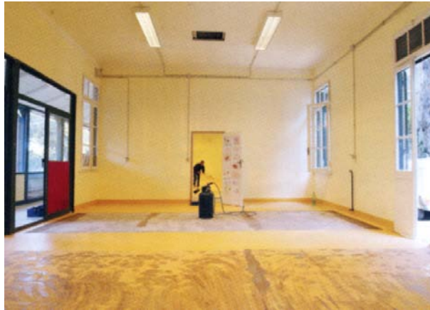
Fig. 205 Fase di cantiere: posa del pavimento in linoleum.
