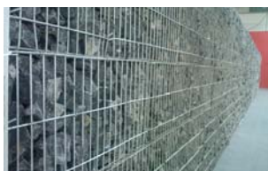
Fig. 369 Utilizzo di materiale proveniente dalla dismissione di un cantiere edile.
