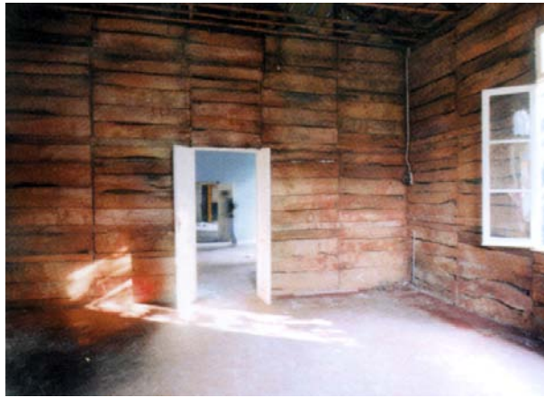
Fig. 204 Fase di cantiere: particolare del balloon-frame .
