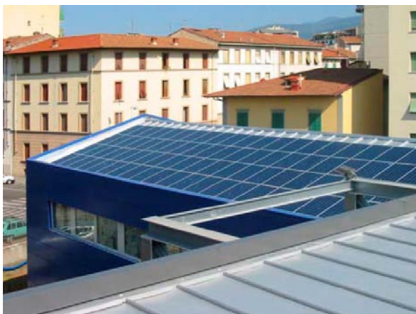
Fig. 227 progetto: copertura fotovoltaica del blocco palestra.
