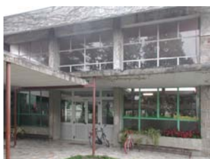
Fig. 72 Scuola primaria "Mons. Mattioli" di Rovigo: chiusura verticale trasparente realizzata con telaio in alluminio e vetro singolo (Fonte: Comune di Rovigo).
