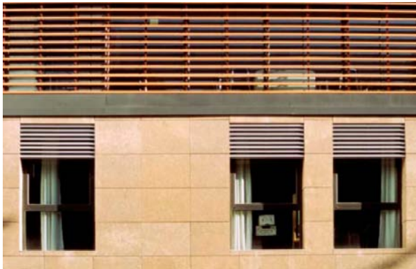
Fig. 226 Progetto: brise soleil in legno.
