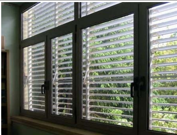
Fig. 241 Frangisole regolabili esterni.
