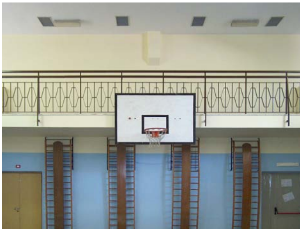
Fig. 238 Prese per l'aria in ingresso all'interno della palestra.
