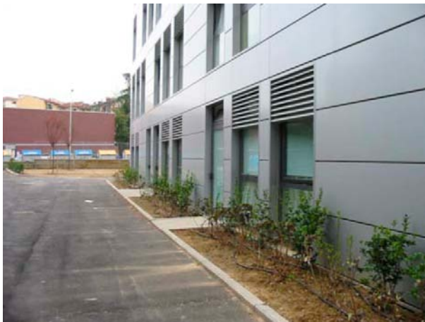
Fig. 223 Progetto: vista dei pannelli di rivestimento in alluminio.
