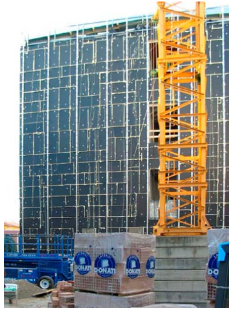
Fig. 218 Immagine di cantiere: fase di posa dell'isolamento termico a cappotto.
