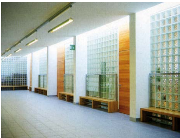
Fig. 210 Vista del corridoio interno di distribuzione alle aule.
