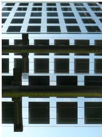
Fig. 445 Istituto Professionale per l'Industria e l'Artigianato, Rovigo – ing. Luigi Ferrari (Provincia di Rovigo). Il sistema prevede l'integrazione di lastre semitrasparenti fisse e di lamelle orientabili attraverso dispositivi a controllo elettronico.
