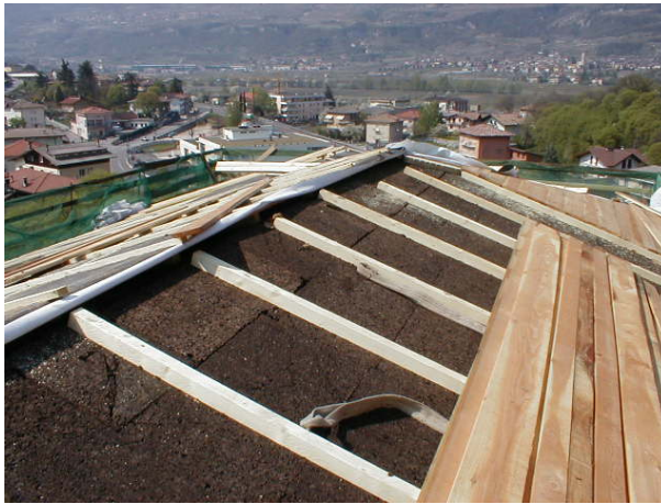
Fig. 145 Progetto: fase di cantiere relativa alla posa in opera degli strati della copertura.
