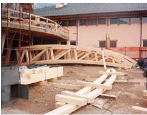
Fig. 365 Lavorazioni a piè d'opera per l'assemblaggio di una trave reticolare in legno lamellare nel cantiere della scuola primaria di Marco di Rovereto (TN) (Fonte: arch. Gianluca Perottoni).
