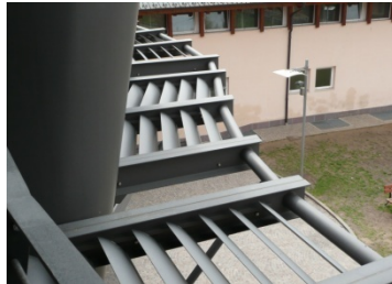
Fig. 450 Scuola primaria, Marco di Rovereto (TN) – arch. Gianluca Perottoni. Filtro solare costituito da frangisole a lamelle fisse orientate in base all'inclinazione dei raggi solari incidenti nei periodi di surriscaldamento.
