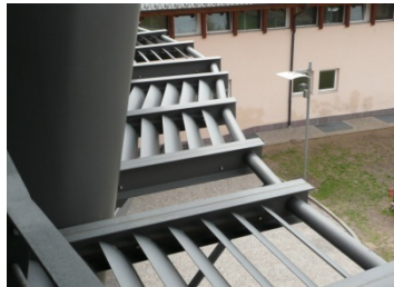
Fig. 442 Scuola primaria, Marco di Rovereto (TN) – arch. Gianluca Perottoni. Filtro solare costituito da frangisole a lamelle fisse orientate in base all'inclinazione dei raggi solari incidenti nei periodi di surriscaldamento.
