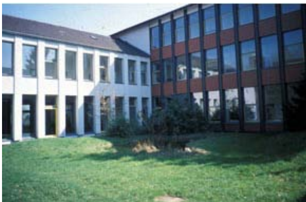
Fig. 105 Vista dell'auditorium dopo l'intervento.
