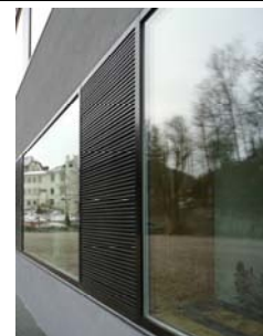
Fig. 425 Scuola primaria di Casteldarne (BZ) – EM2 Architetti. Griglia esterna di alloggiamento delle condotte di ventilazione integrata con il sistema vetrato.
