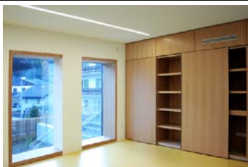
Fig. 388 Scuola per l'infanzia di Monguelfo (BZ) – EM2 Architetti. Elementi di arredo per l'alloggiamento del dispositivo di ventilazione (Foto: EM2 Architetti).
