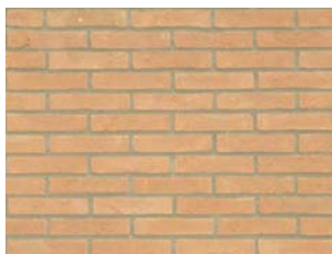
Fig. 60 Parete in mattoni faccia a vista di tipo standardizzato.
