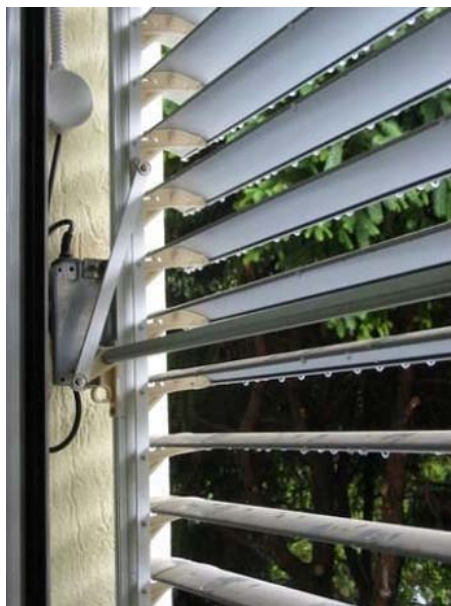
Fig. 242 Dispositivo di regolazione dell'inclinazione dei frangisole.
