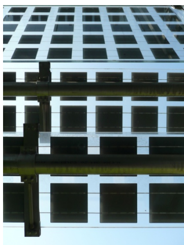
Fig. 464 Istituto Professionale per l'Industria e l'Artigianato, Rovigo – ing. Luigi Ferrari (Provincia di Rovigo). Moduli semitrasparenti orientabili a celle fitte.
