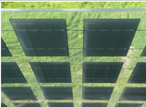
Fig. 252 Particolare della lastra fotovoltaica semitrasparente.
