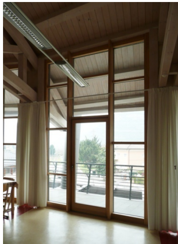
Fig. 447 Scuola primaria, Marco di Rovereto (TN) – arch. Gianluca Perottoni. Posizionamento di schermature interne flessibili a protezione delle ampie chiusure trasparenti.
