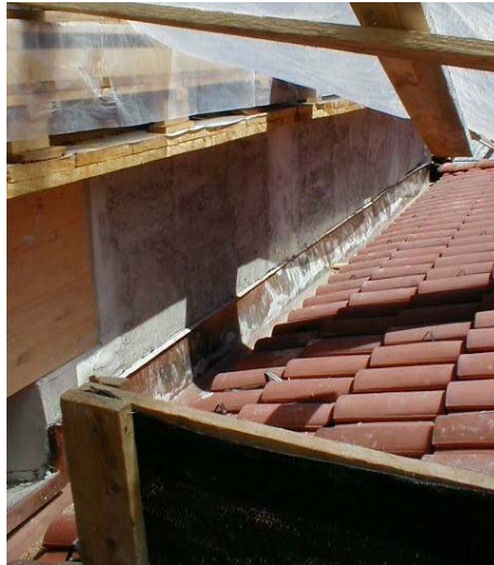
Fig. 146 Progetto: fase di cantiere relativa all'ultimazione dei lavori di posa della copertura.
