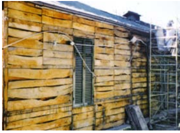
Fig. 377 Scuola per l'infanzia S. Gregorio al Celio a Roma. Geom. Edoardo Bellazzecca. Fase di rimozione della copertura in amianto (Foto: Oleotto E., Edifici scolastici ecocompatibili , pag. 164, cfr. bibliografia).
