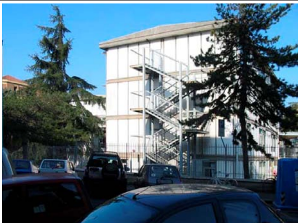
Fig. 212 Edificio esistente: immagine esterna del corpo di fabbrica della scuola primaria.
