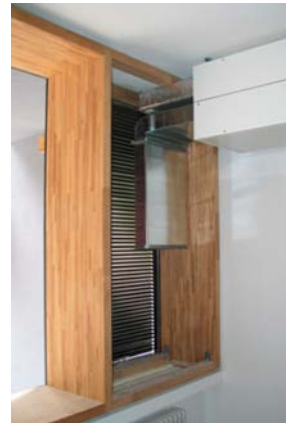
Fig. 182 Progetto: predisposizione della griglia esterna (immagine interna durante la posa in opera).
