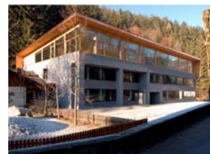
Fig. 362 La scuola primaria di Casteldarne (BZ) dopo l'intervento di riqualificazione energetica. La tecnologia del "cappotto termico" ha donato una nuova immagine architettonica al manufatto edilizio (Fonte: EM2 Architetti – Brunico (BZ)).
