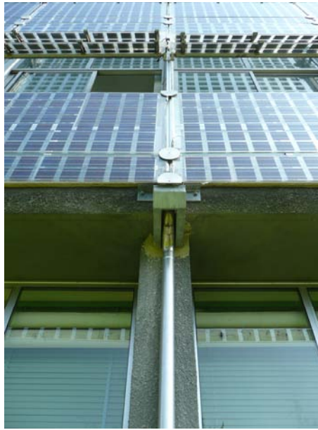
Fig. 255 Particolare del passaggio del pluviale.
