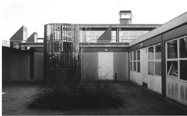
Fig. 90 Vista di una corte interna.
