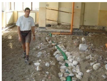
Fig. 379 Scuola primaria a Fonzaso – loc. Arten (BL). Posa in opera del tubo forato all'interno del sottofondo (Foto: prof. G. Zannoni).
