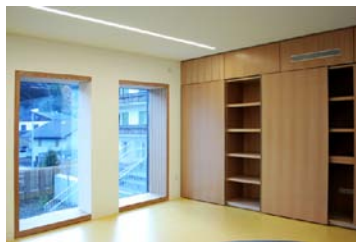
Fig. 421 Scuola per l'infanzia di Monguelfo (BZ) – EM2 Architetti. Elementi di arredo per l'alloggiamento del dispositivo di ventilazione (Foto: EM2 Architetti).
