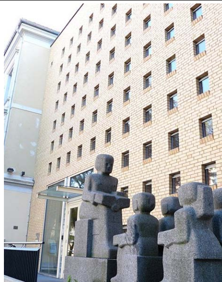
Fig. 84 Vista del fabbricato di unione tra i due edifici esistenti; il nuovo fabbricato ospita nuovi locali tra cui la mediateca e la biblioteca.
