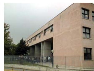
Fig. 65 Istituto professionale per servizi alberghieri e ristorazione "A. Moro" di Adria (RO). L'edificio, costruito nel 1990, presenta una chiusura opaca costituita da struttura in pilastri in c.a., tamponamenti in laterizi forati e intonaco esterno (Fonte: Provincia di Rovigo).
