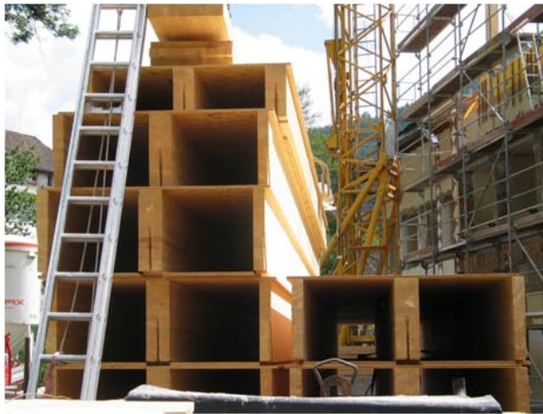
Fig. 175 Progetto: moduli preassemblati per la copertura.
