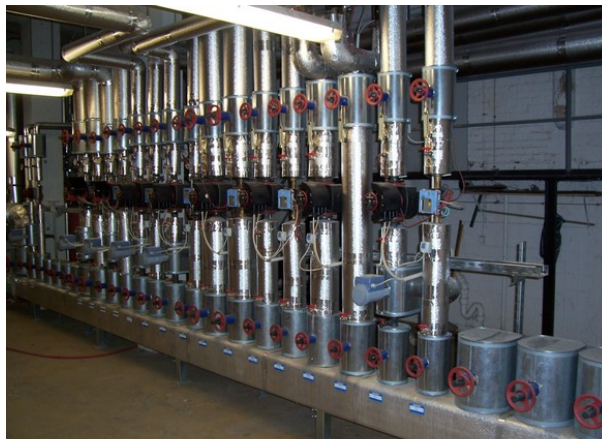
Fig. 106 Impianto di distribuzione del calore.
