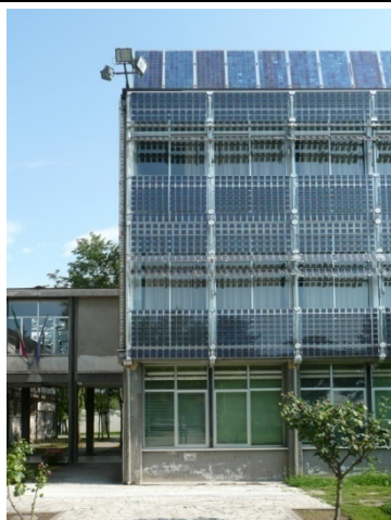
Fig. 409 Istituto Professionale per l'Industria e l'Artigianato, Rovigo – ing. Luigi Ferrari (Provincia di Rovigo). Filtro solare realizzato attraverso l'applicazione di moduli fotovoltaici semitrasparenti.
