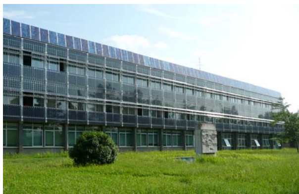
Fig. 248 Vista del fronte principale a seguito dell'intervento.
