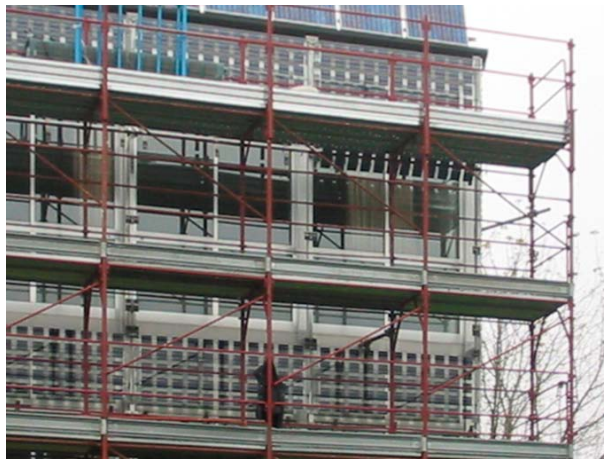
Fig. 246 Fase di cantiere: montaggio dei moduli fotovoltaici.
