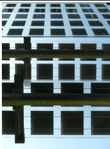
Fig. 410 Istituto Professionale per l'Industria e l'Artigianato, Rovigo – ing. Luigi Ferrari (Provincia di Rovigo). Il sistema prevede l'integrazione di lastre semitrasparenti fisse e di lamelle orientabili attraverso dispositivi a controllo elettronico.
