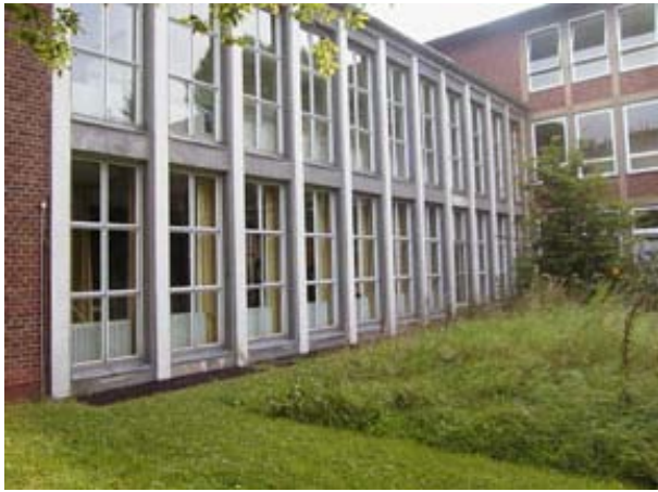
Fig. 103 Vista dell'auditorium prima dell'intervento.
