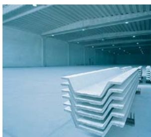
Fig. 62 Edificio completamente prefabbricato costituito da componenti prodotti interamente in officina e successivamente assemblati in cantiere.
