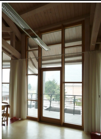
Fig. 404 Scuola primaria, Marco di Rovereto (TN) – arch. Gianluca Perottoni. Posizionamento di schermature interne flessibili a protezione delle ampie chiusure trasparenti.
