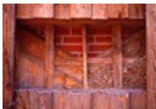
Fig. 468 Finestra didattica sulla tecnologia adottata per il risparmio dell'energia attraverso l'involucro dell'edificio (Fonte: PAEA – Progetti alternativi per l'energia e l'ambiente).
