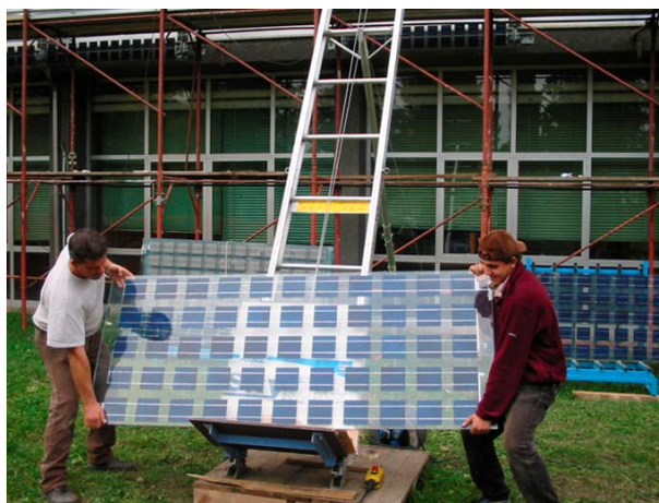
Fig. 247 Fase di cantiere: particolare dei moduli fotovoltaici.
