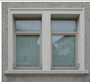
Fig. 446 Scuola primaria, Marco di Rovereto (TN) – arch. Gianluca Perottoni. Posizionamento di schermature interne flessibili a protezione della chiusura trasparente.
