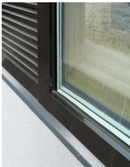
Fig. 171 Progetto: sistema degli infissi della porzione di edificio esistente costituiti da telaio in legno – alluminio con doppio vetrocamera basso emissivo.
