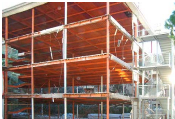
Fig. 216 Immagine di cantiere: fase di demolizione dei tamponamenti esistenti.
