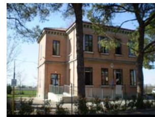
Fig. 63 Scuola primaria di Ferrara – frazione di Pontegradella. L'edificio, costruito nel 1915, presenta una chiusura opaca in muratura di laterizi pieni a tre e due teste (rispettivamente al piano terra e al piano primo) (Fonte: Comune di Ferrara).
