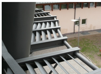
Fig. 407 Scuola primaria, Marco di Rovereto (TN) – arch. Gianluca Perottoni. Filtro solare costituito da frangisole a lamelle fisse orientate in base all'inclinazione dei raggi solari incidenti nei periodi di surriscaldamento.
