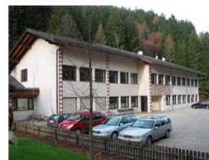
Fig. 361 La scuola primaria di Casteldarne (BZ) prima dell'intervento di riqualificazione energetica (Fonte: EM2 Architetti – Brunico (BZ)).
