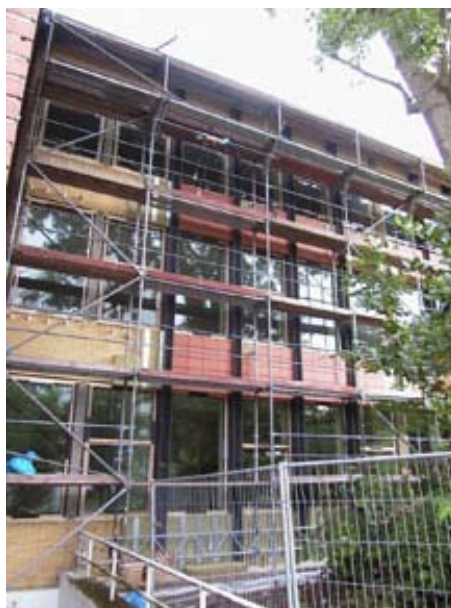
Fig. 102 immagine di cantiere.
