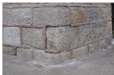
Fig. 304 Scheda tipo riguardante alcuni degli elementi che costituiscono il macroelemento facciate (Fonte: EPIQR Rénovation Sarl).
