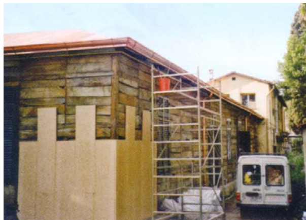
Fig. 203 Fase di cantiere: montaggio dei pannelli in legno-magnesite.
