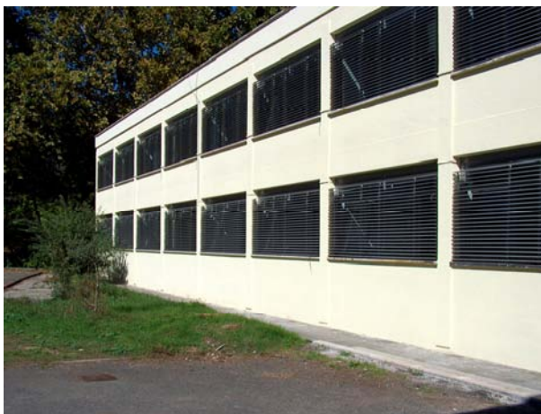
Fig. 240 Sistema di schermature solari esterne regolabili.
