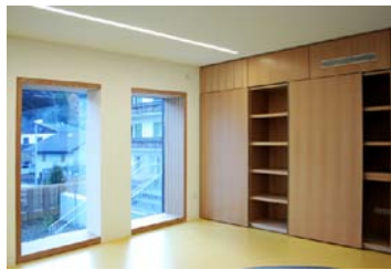
Fig. 372 Scuola per l'infanzia di Monguelfo (BZ) – EM2 Architetti. Elementi di arredo per l'alloggiamento del dispositivo di ventilazione (Foto: EM2 Architetti).
