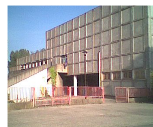
Fig. 71 Scuola secondaria di I grado "Bonifacio" di Rovigo: chiusura verticale eseguita con pannelli in c.a. prefabbricato (Fonte: Comune di Rovigo).
