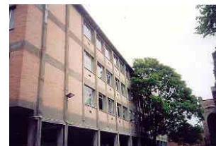
Fig. 64 Scuola secondaria di I grado "D. Alighieri" di Ferrara. L'edificio, costruito alla fine degli anni Sessanta, presenta una chiusura opaca costituita da pilastri in c.a. gettati in opera e tamponamenti in mattoni pieni (Fonte: Comune di Ferrara).
