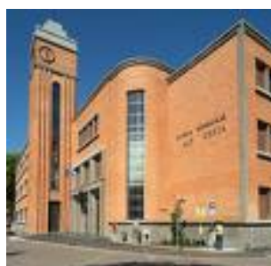
Fig. 67 Scuola Primaria "Alda Costa" di Ferrara (Fonte: Comune di Ferrara).
