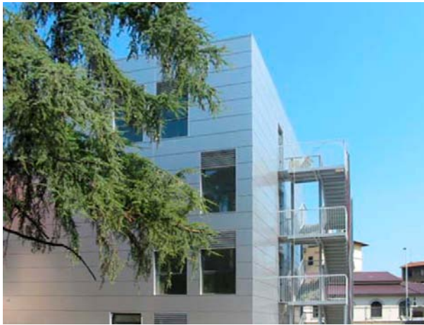
Fig. 225 progetto: vista del corpo scale antincendio.
