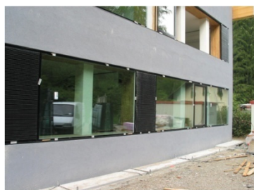
Fig. 397 Scuola primaria, Casteldarne (BZ) – EM2 Architetti. I nuovi infissi sono stati montati al filo esterno della parete, in linea con l'isolamento a cappotto, per ridurre le disomogeneità termiche dell'involucro (Foto: EM2 Architetti).
