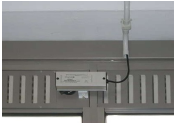
Fig. 378 Scuola secondaria secondo livello "R. Fucini", Roma – Comune di Roma. Attuatori per l'apertura degli infissi in relazione ai livelli di CO 2 presenti nell'aria (Foto: AESSE).
