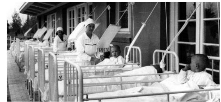
Vista general del Pavelló Hèlios i detall de la galeria de cura amb els infants malalts. © AHDB
