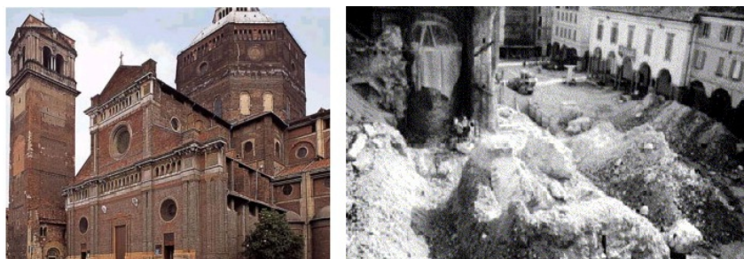
Figura 2 – Torre Cívica de Pavia – Antes e depois do colapso (adaptado de Oliveira 2016)
