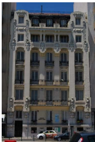
Figura 19: Vista da fachada do edifício Luíz Rau em Lisboa [Almeida et al., 2017]
