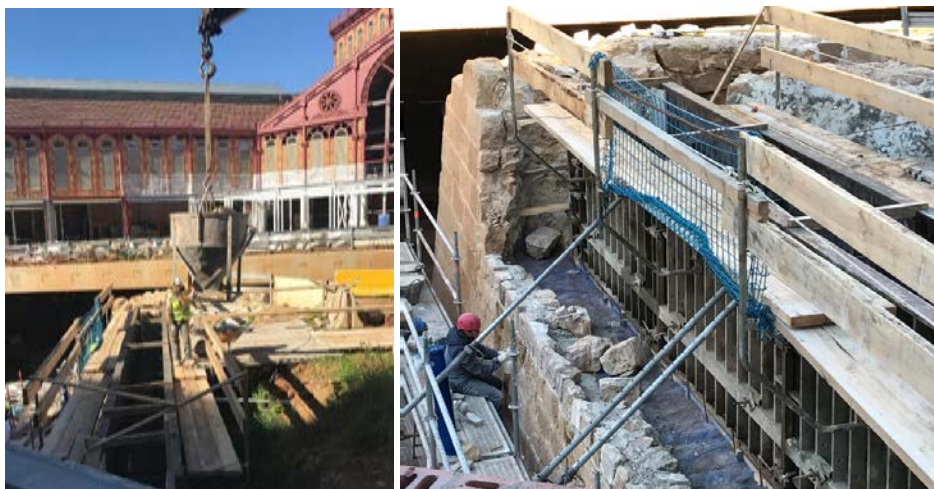
Figura 10. Proceso de hormigonado del Baluarte de la muralla medieval de Barcelona, bajo el mercado de Sant Antoni.
