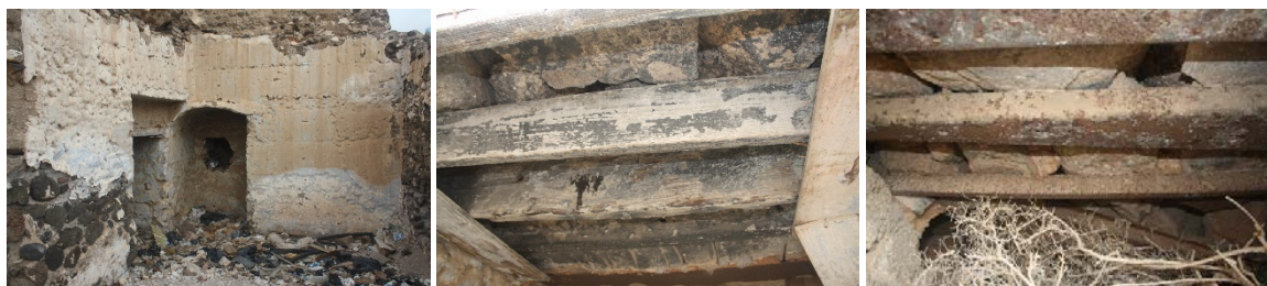
Figura 7: Acceso, embocadura y parrilla. Horno TEL 07 (Fuente: Manzano, J.)
