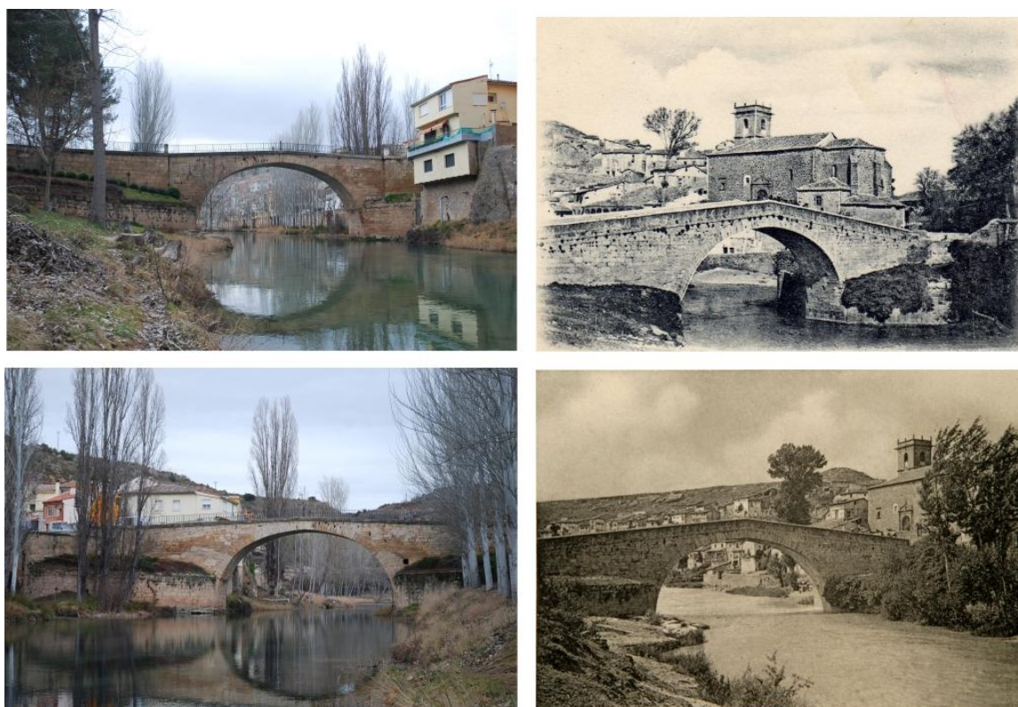
Figura 2: Detalle del puente desde aguas arriba y abajo (izquierda) y algunas instantáneas históricas (derecha). Fuente: ABN Patrimonio.
