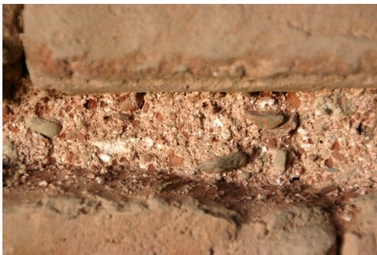
Figura 2. Detalle de una junta de mortero de cal con chamota correspondiente a una fábrica de ladrillo de la Alhambra de Granada. Fotografía JRRR.
