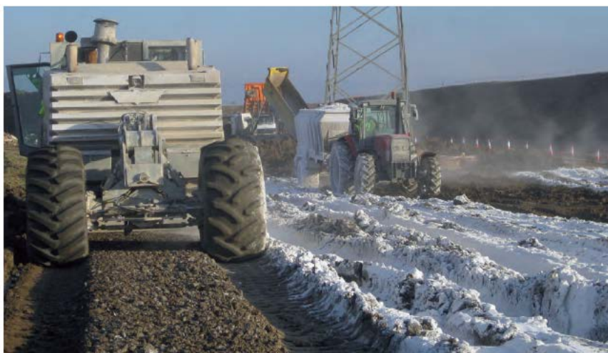
Figura 2: Estabilización de lodos con cal viva. (Fuente: ROP)
