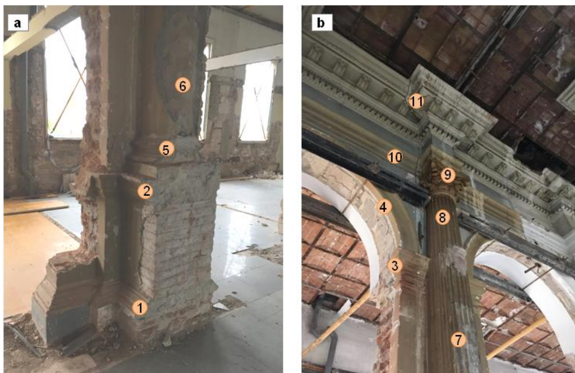
Figura 8 a y b: Ejemplo de la numeración de las piezas prefabricadas de uno de los pórticos de la sala de la primera planta
