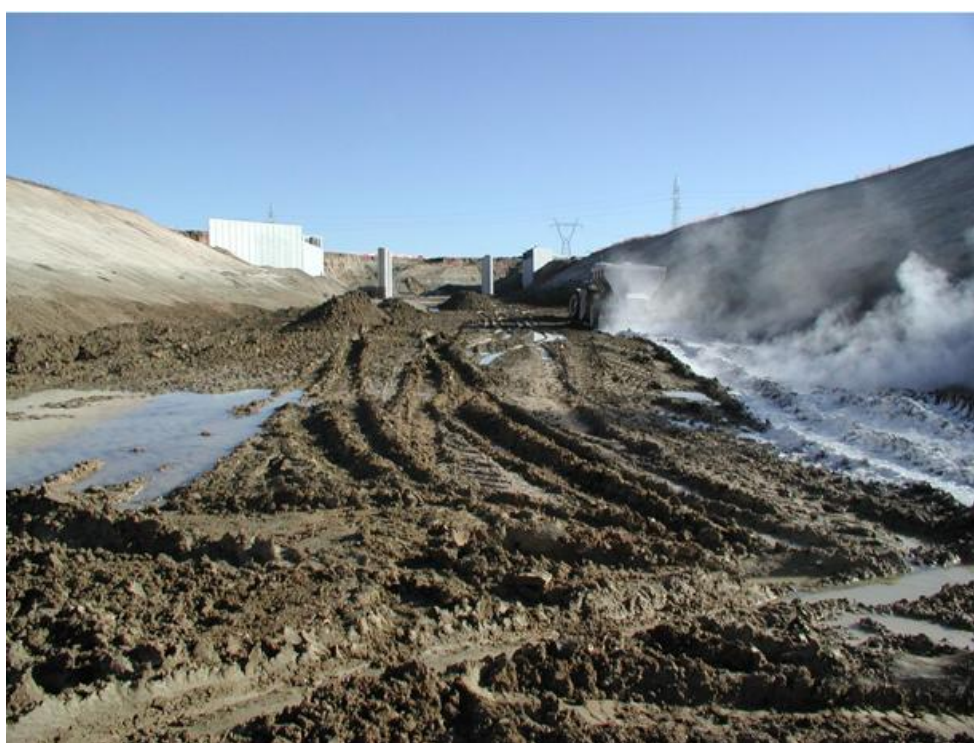
Figura 1: Secado de lodos mediante cal viva.
