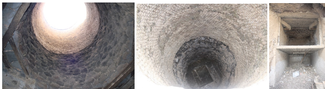
Figura 5: Vistas interiores de la cuba y hogar del TEL 02 (Fuente: Manzano, J.)
