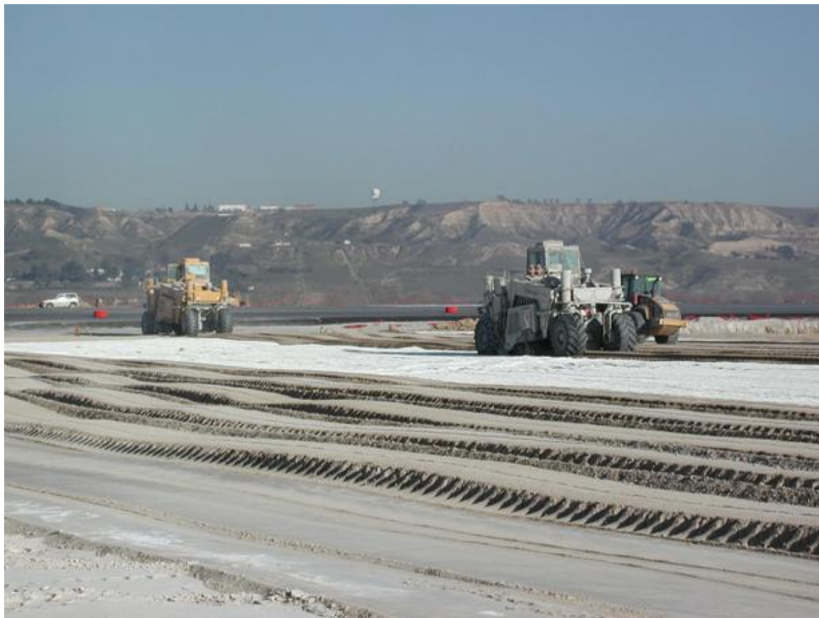
Figura 5: Tratamiento con cal en estabilización mixta.
