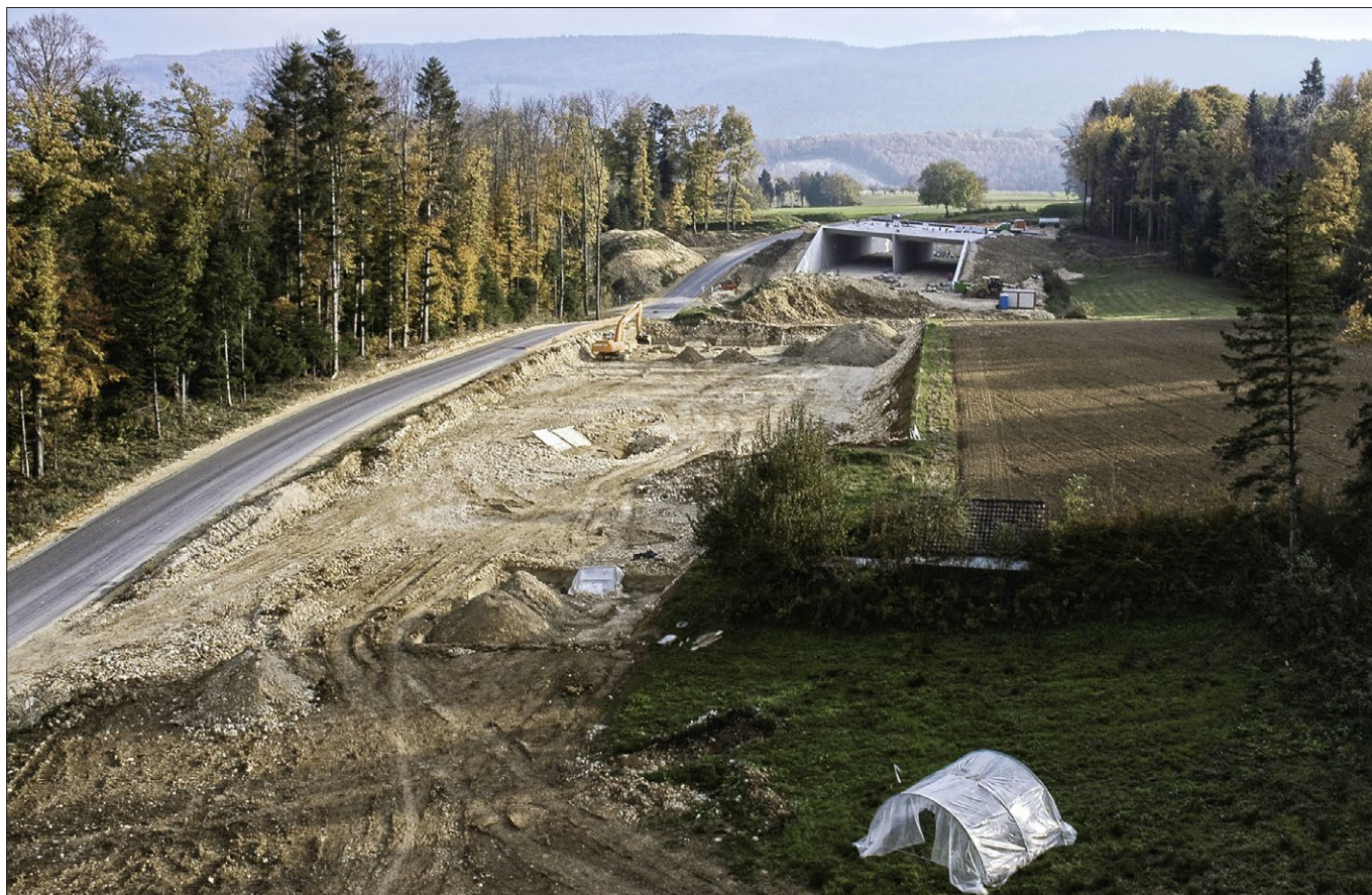
Courtedoux-Bois de Sylleux: vue vers le sud-est (2007).
