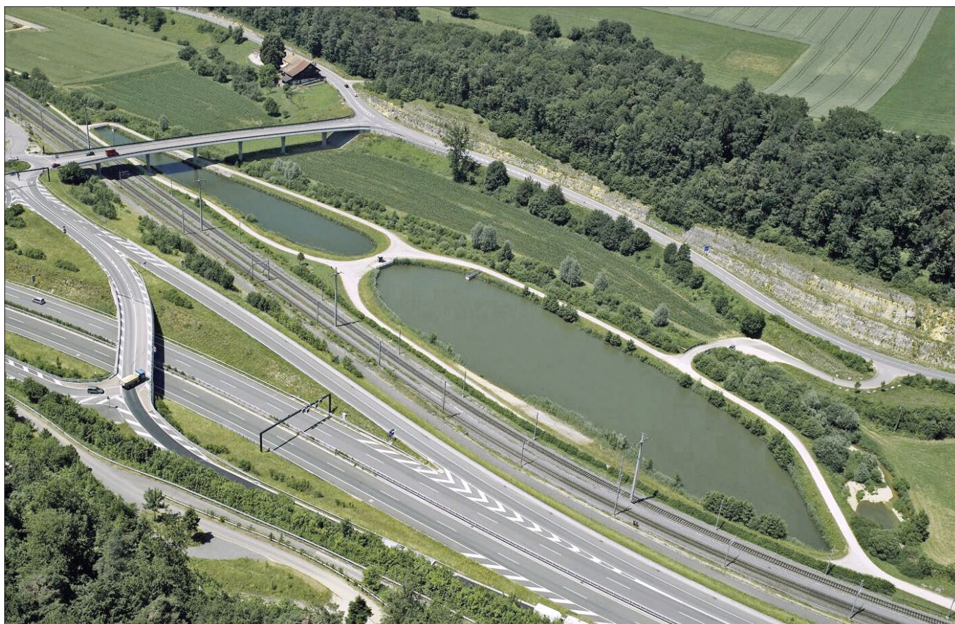
Porrentruy - Roche de Mars: vue aérienne (2006).
