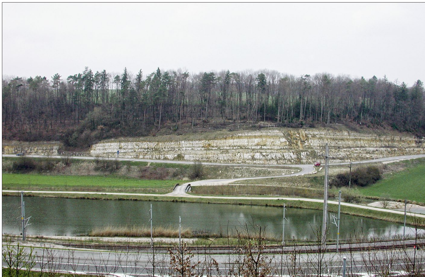
Porrentruy-Roche de Mars: vue vers le nord (2001).
