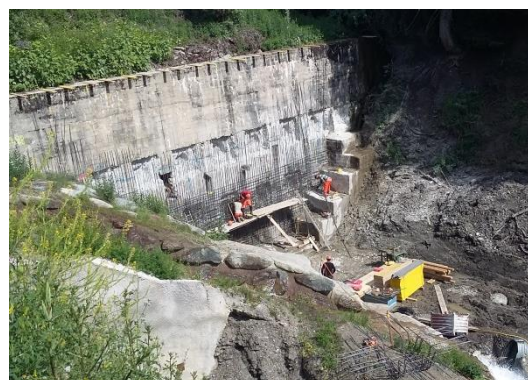
Figure 7: Digue supérieure du lac Icogne
