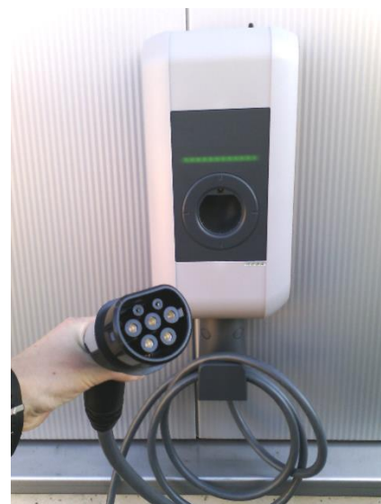
Abbildung 7: KEBA-Ladesäule mit Typ 2 Stecker
