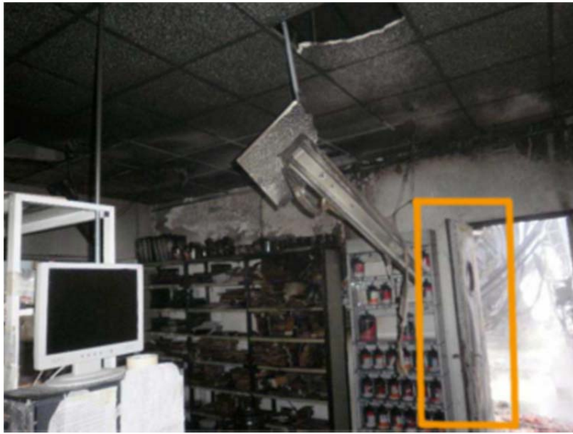
Imagen 5. Puerta de sectorización abierta.
