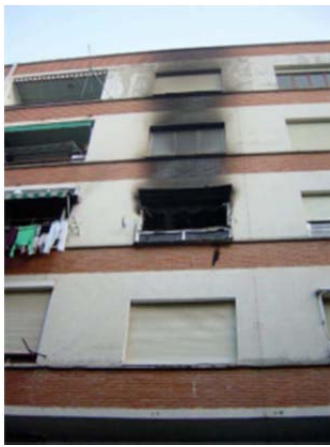
Imagen 12. Distancia suficiente entre ventanas.
