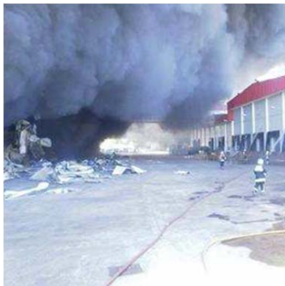
Imagen 14. Importancia de la distancia entre edificios.
