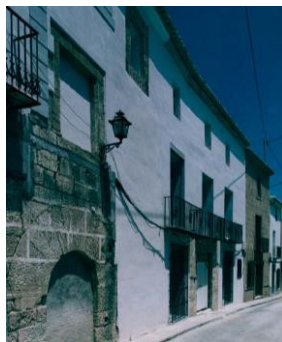
Figura 5: La fachada del XVII se ha sacado a la luz en el lateral de la dieciochesca. Fuente. Fotografía propia
