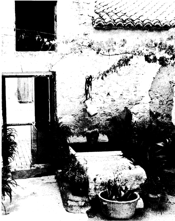
Figura 3. Detalle del pozo y pila existente en el patio de la casa.
