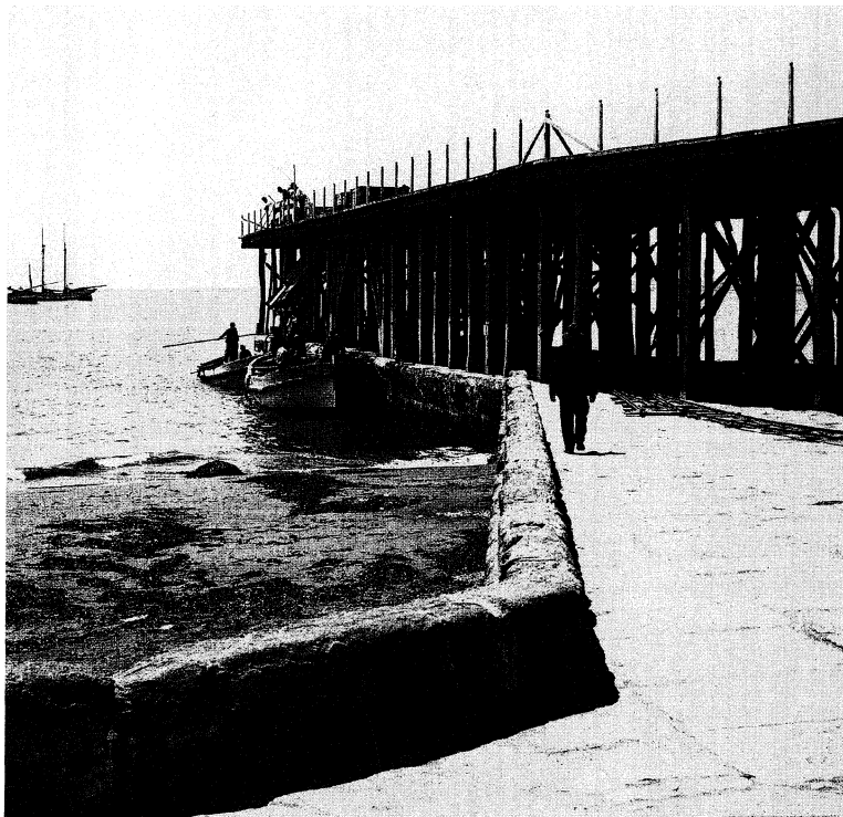
Figura 1. Cargadero de sal existente en el puerto de Torrevieja a principios del siglo XX.
