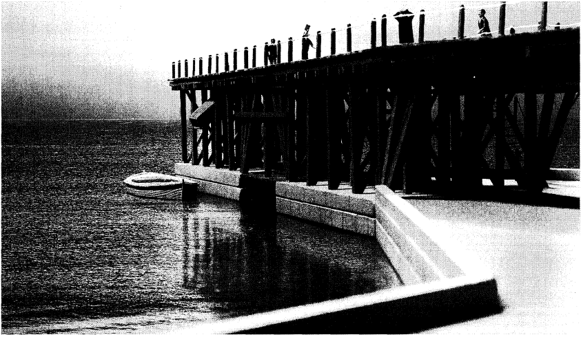
Figura 2. Detalle de como quedaría el reconstruido cargadero de sal.
