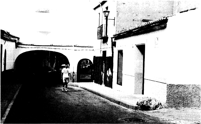
Figura 4. En primer término, fachada de la casa de Miguel Hernández.
