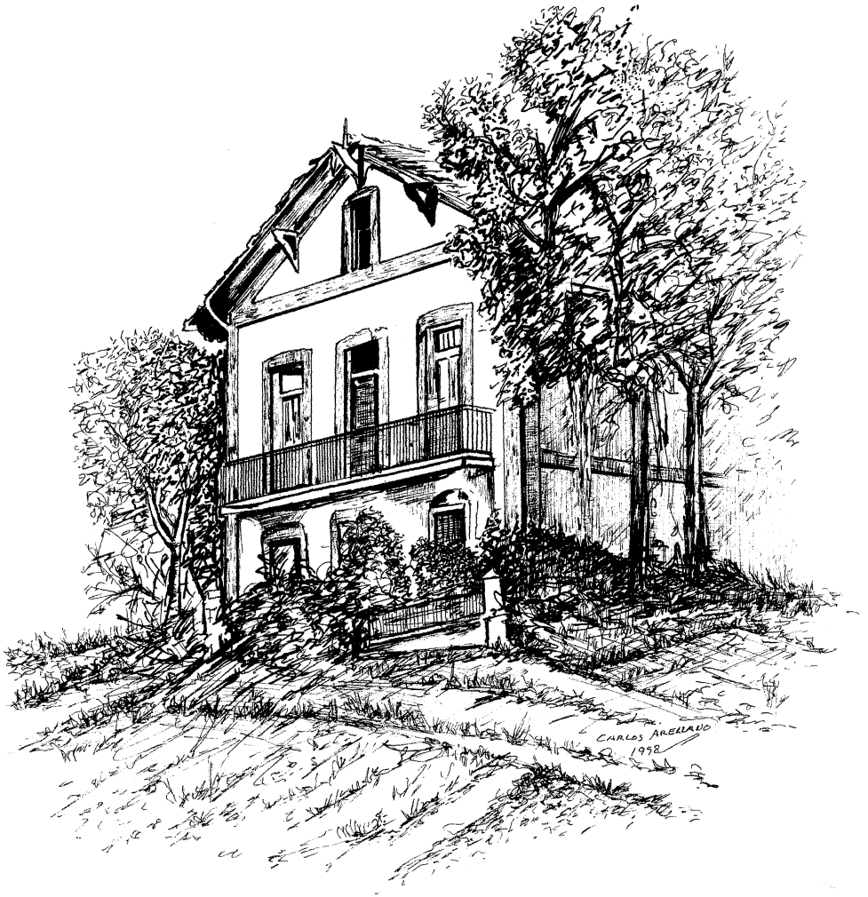
Mansión en estado ruinoso correspondiente a la finca Miralrío de La Juliana.
