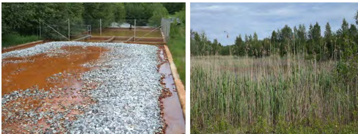
Kuva 26. Kotalahden suljetun kaivosalueen kalkkikiven puskurointiin perustuva vedenpuhdistamo (vasemmalla). Kasvillisuus on levittänyt hyvin rikastushiekan jätealueella muodostaen metallien sitoutumiseen soveltuvia kosteikkoja (oikealla), Leppävirta, Pohjois-Savo. (© A. Tornivaara, GTK)
