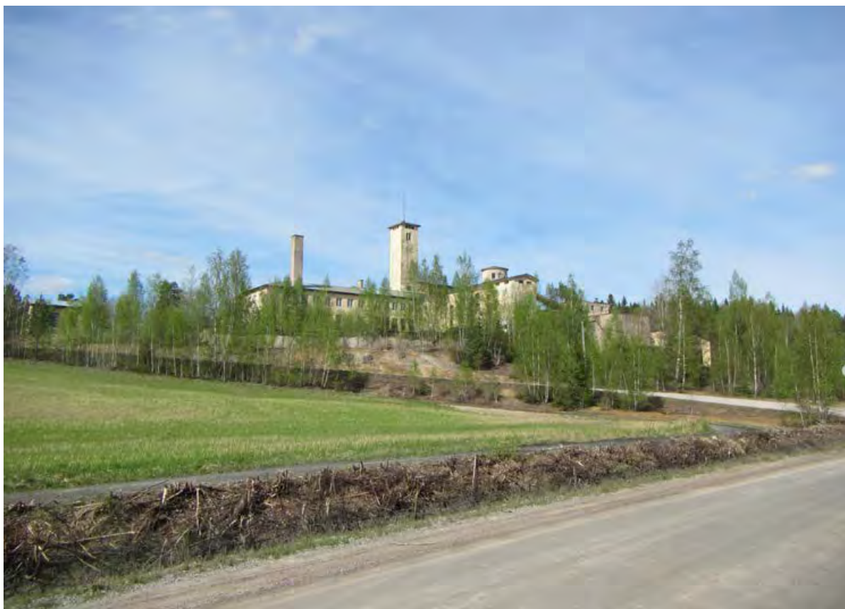
Kuva 6. Aijalan suljetun kaivoksen rikastamo. Maastosta erottuu selvästi ruskeaksi värjäytyneet tiepenkereet, joissa käytetty kaivosjätteitä. (© A. Tornivaara, GTK)
