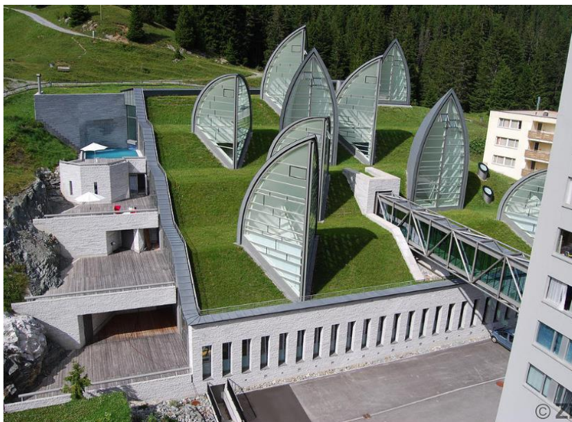
Figura 16: Hotel Spa, Tschuggen-Bengoase, Suíça (Zinco, 2016)
