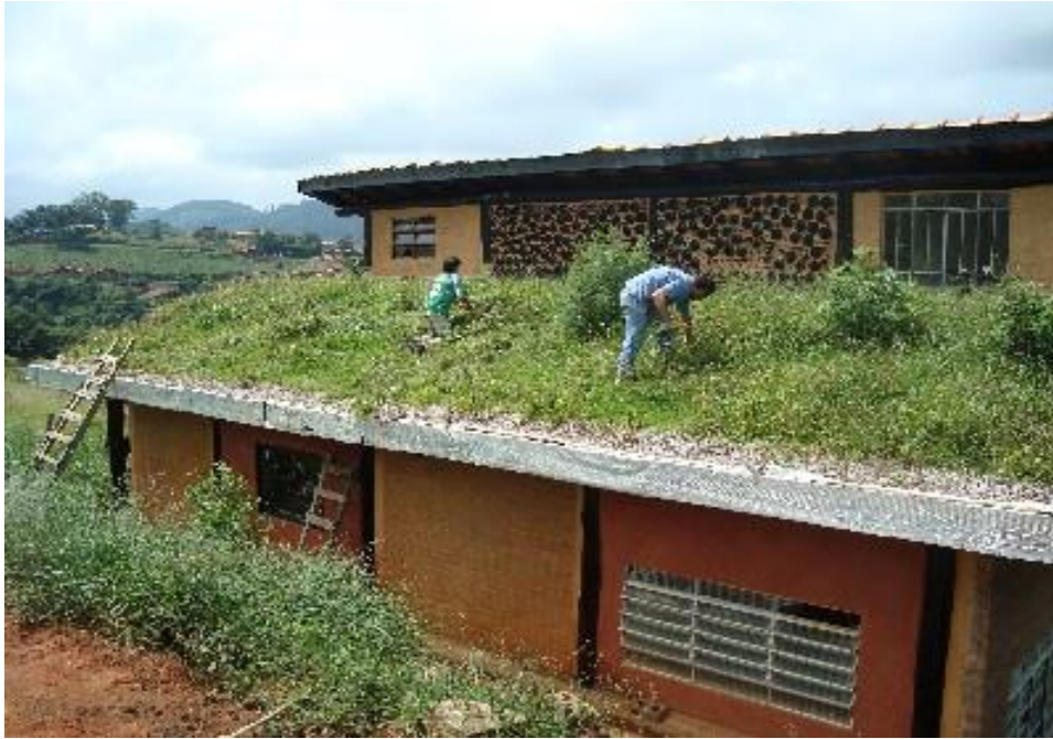
Figura 13: Processo de Limpeza de uma cobertura verde
