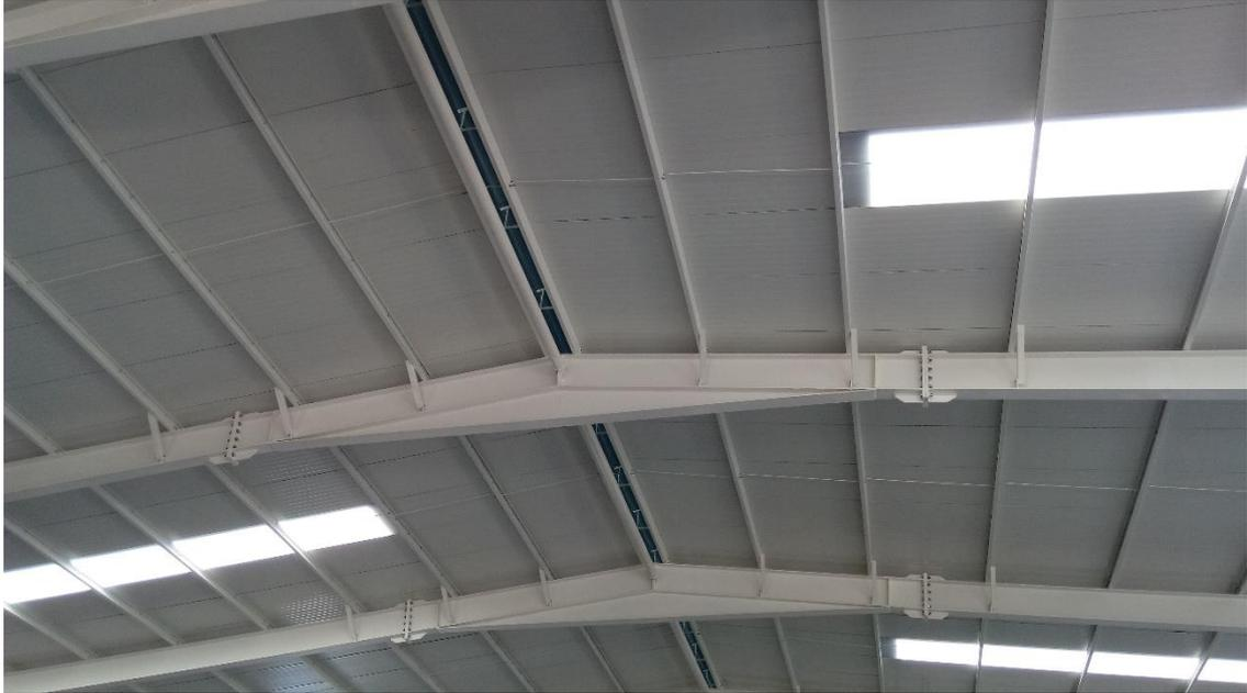
Figura 21 – Exemplo de ligação e travamento das anas e estantes elementos de cobertura
