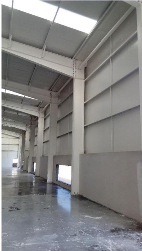
Figura 22 – Exemplo ligação viga/pilar e restantes elementos da fachada
