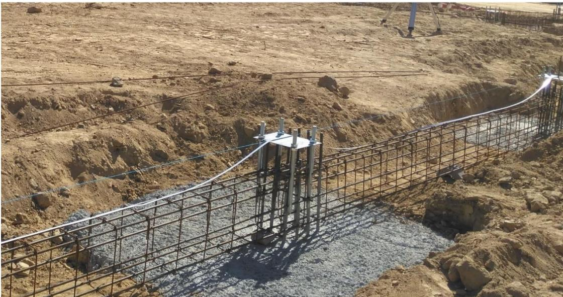
Figura 18 – Exemplo de fixação de pernos para base de pilares
