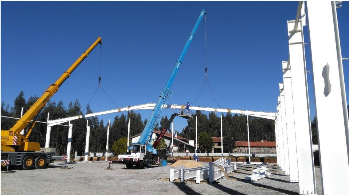
Figura 19 -Colocação de uma asna em obra
