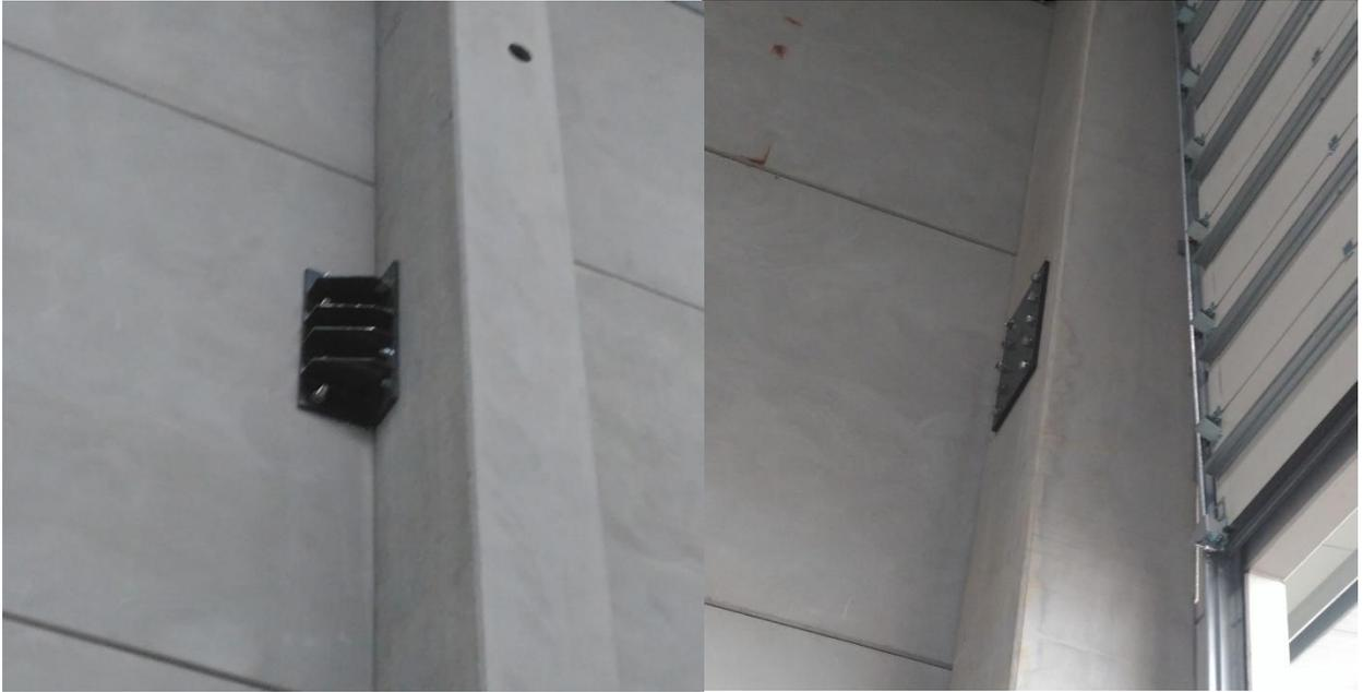
Figura 37 – Peça transmissão esforços para o pilar (esquerda) e Chapa de amarração (direita)
