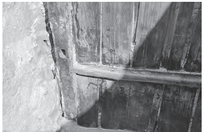
5. 井戸3井戸枠（北辺）角柱・棧木組合せ状況（南から）
