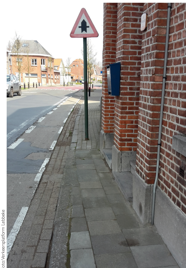
De paal op dit smalle voetpad maakt de doorgang onmogelijk.
