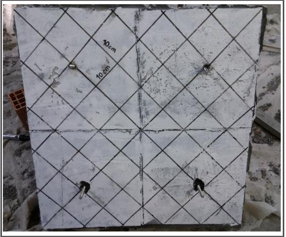
Şekil 3.18: Duvar yüzeyine karolaj yapımı.
