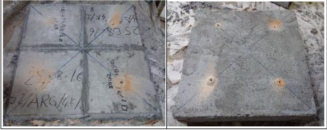
Şekil 3.15: Tijlerin yerleştirileceği ankraj delikleri.
