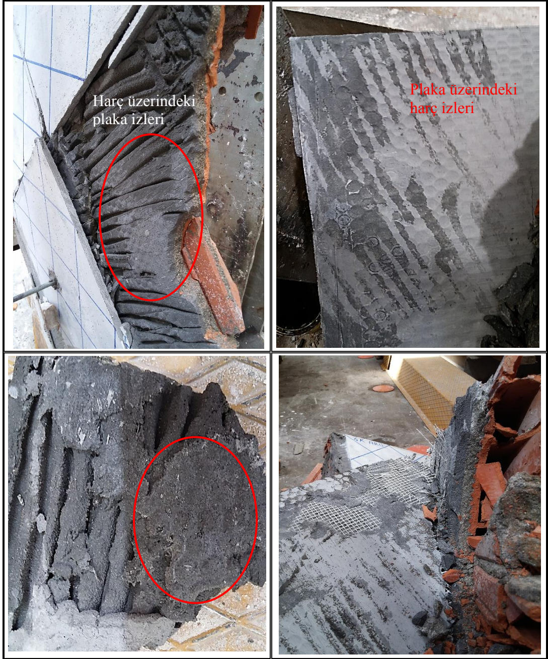
Şekil 3.42: Bağlayıcı harç üzerindeki plaka izleri ve plaka üzerindeki harç izleri.
