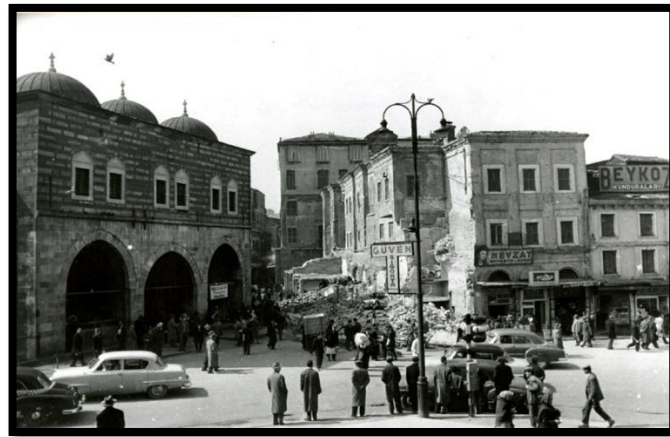
Figure 3.11 : The demolition of a building around Mısır Çarşısı ( http://kiricioglu.blogspot.com.tr )
