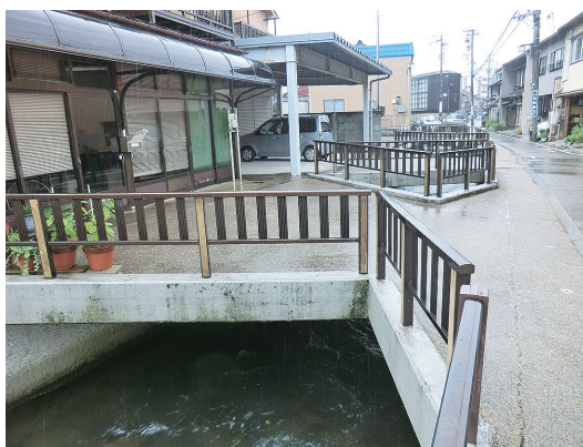
写真4 開渠部を確保するためにくびれた私有橋 (2014年8月著者撮影)
