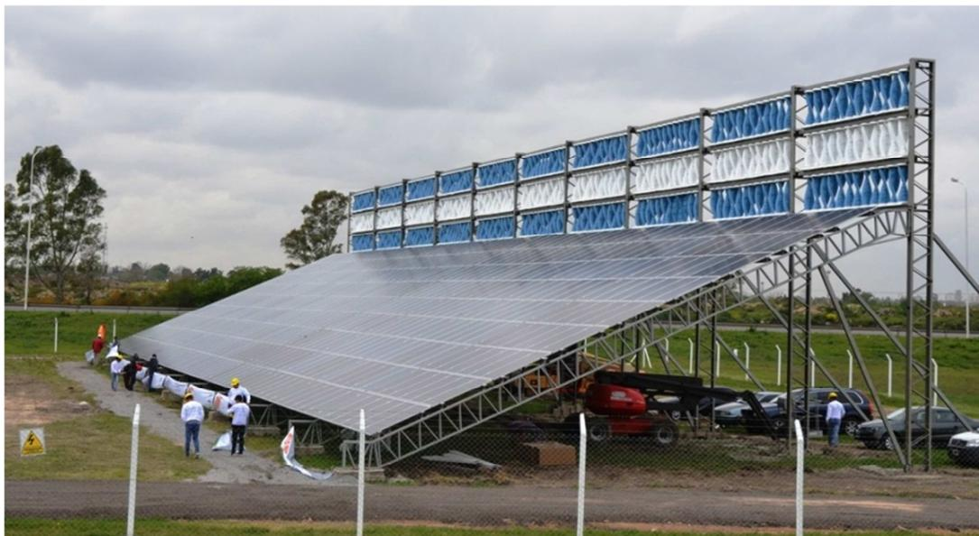
Figura 4. Generación híbrida eólica-fotovoltaica autopista Camino del Buen Ayre – CEAMSE.
