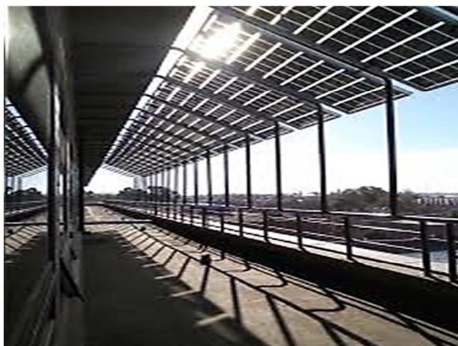
*Figura 1. Pérgola edificio Tandar (CNEA) - Instalación de paneles fotovoltaicos.*
