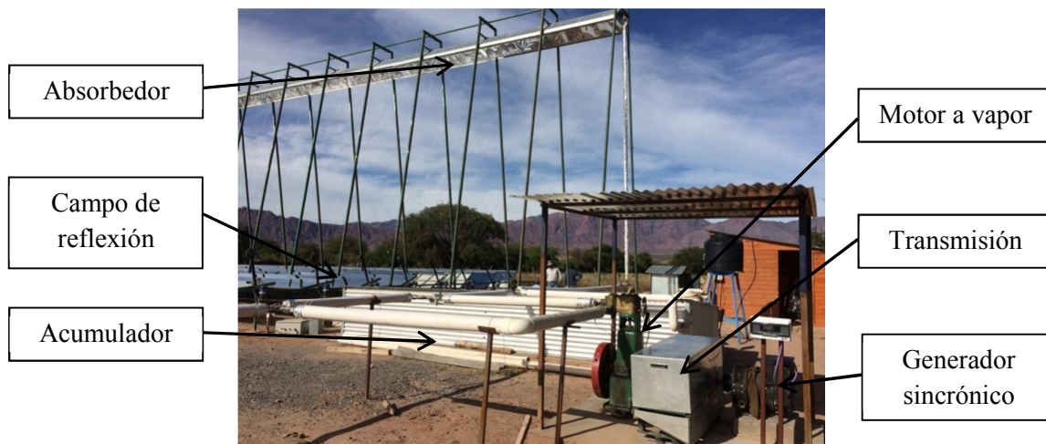
Figura 2: partes del sistema Fresnel Lineal.
