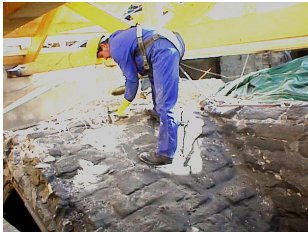
Figura 5.4: Encalado de bóvedas de la nave central
