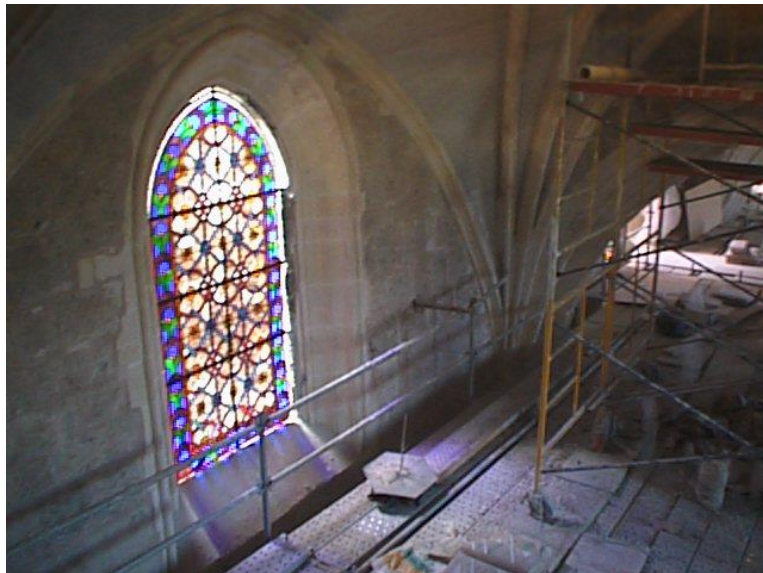
Figura 5.6: Plataforma de trabajo de andamiaje a 6 m.
