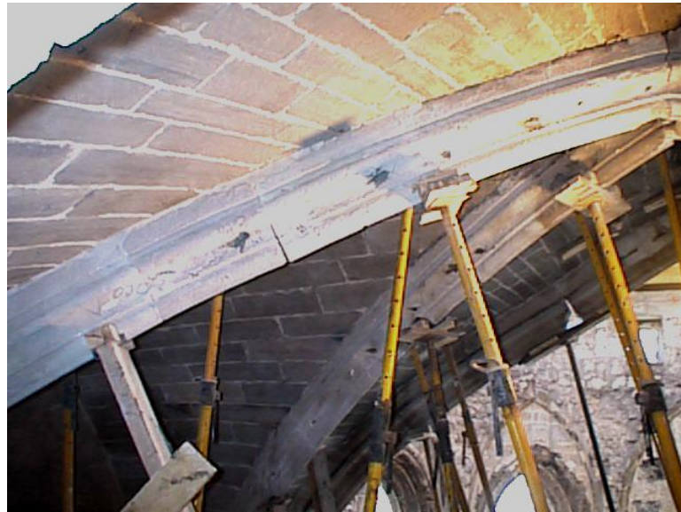
Figura 5.2: Apeo interior de bóvedas de la nave central
