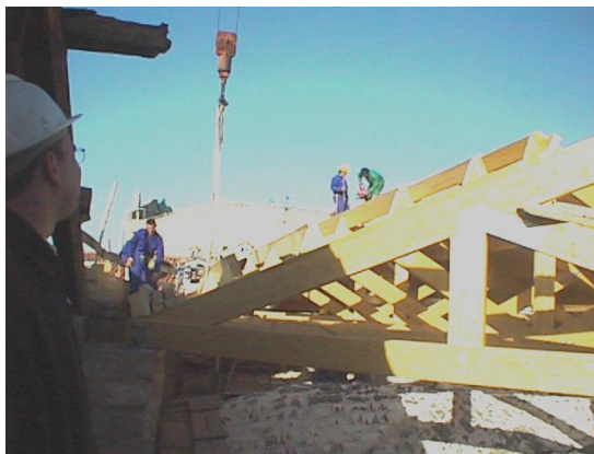
Figura 5.3: Ejecución de cerchas en la nave central
