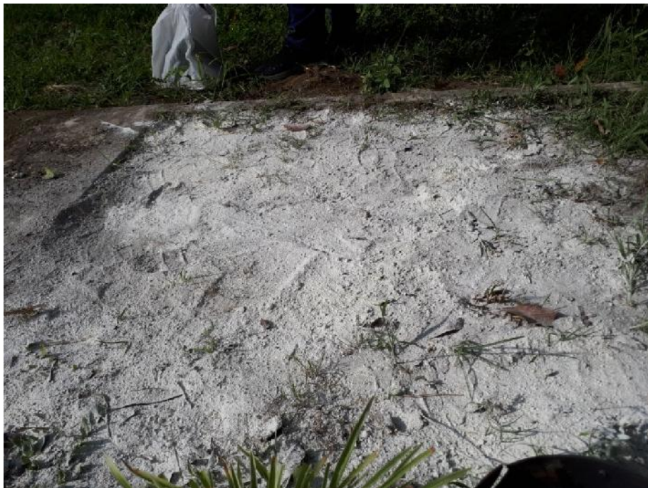
Foto 7. Media kapur sebagai tempat tolakan
