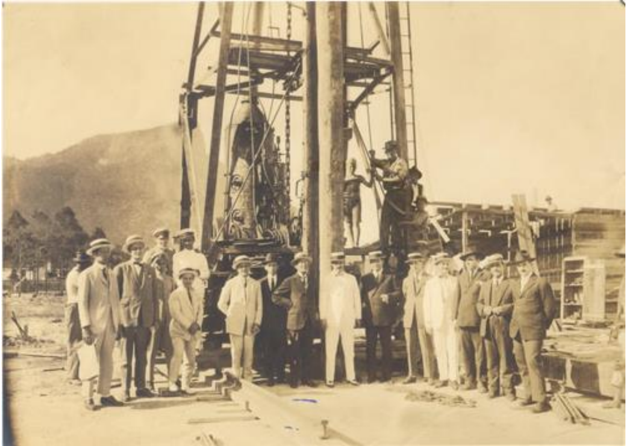
Figura 1 – Estacas nas fundações do hipódromo da Gávea, no Rio de Janeiro
