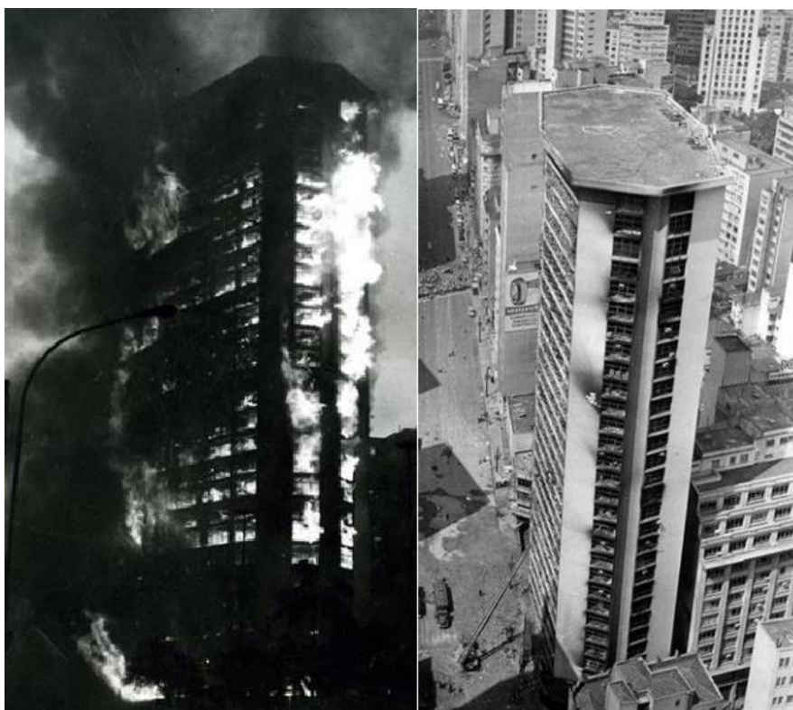
Figura 01 - Incêndio Edifício Andraus, São Paulo, 1972
