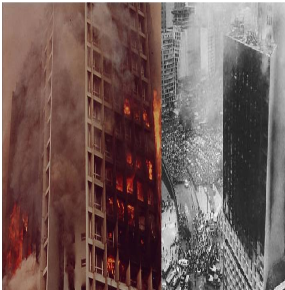
Figura 02 - Incêndio Edifício Joelma, São Paulo, 1974
