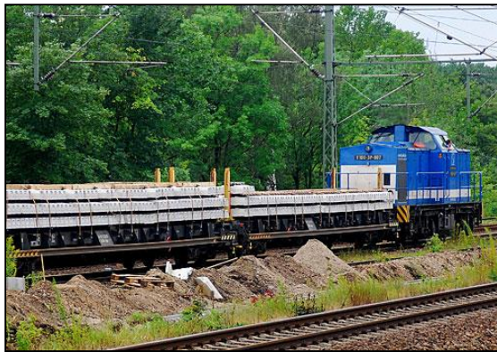
Abbildung 24: Gestapelte Gleisjoche auf einem Eisenbahngüterwagen
