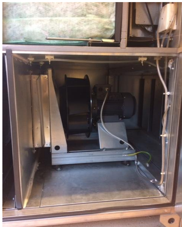
Bilde 11. Nye direkte-drevne kammervifter med frekvensomformere.
