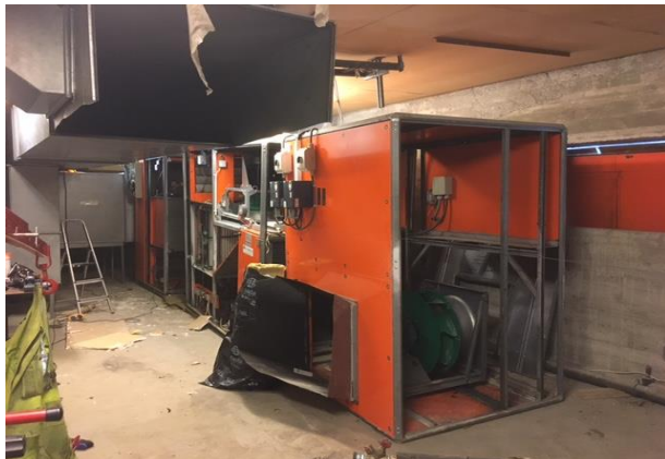
Bilde 7. Svømmehallen, demontering av bassengaggregat, store basseng.
