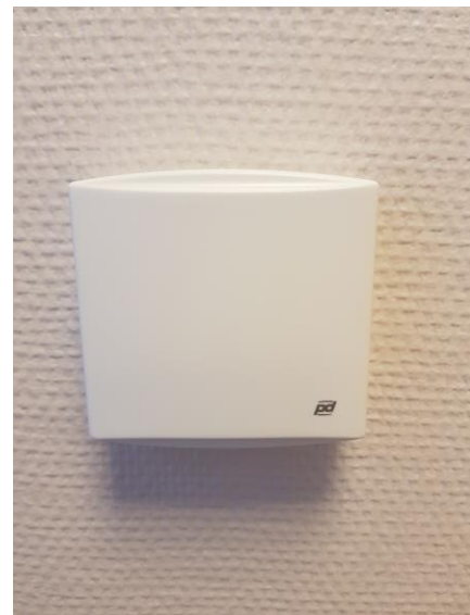
Bilde 5. Styreenhet-termostat til varmeovner. Foto: Rindal kommune
