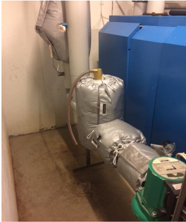
Bilde 12. Etter-isolering av varmeanlegg. Foto: Surnadal kommune
