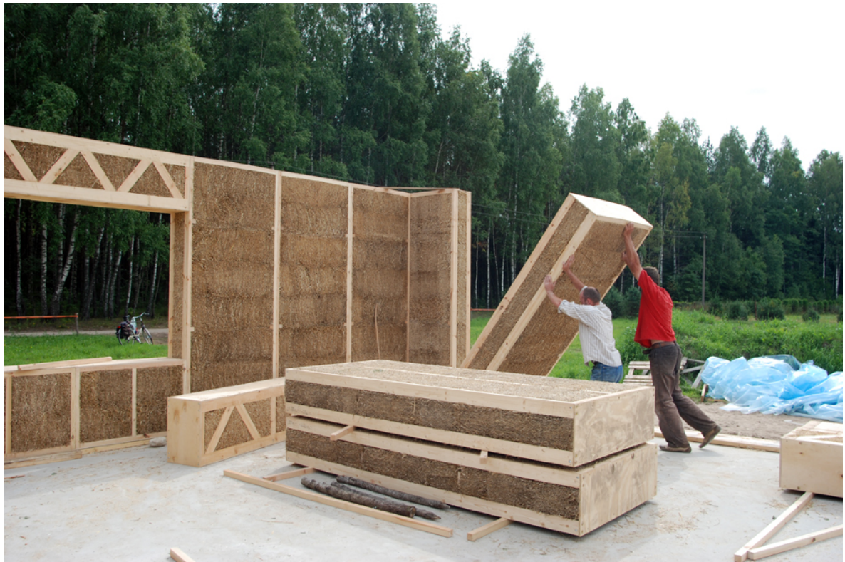
(Obr.4: Rychlá montáž stěn z modulových dílců )
